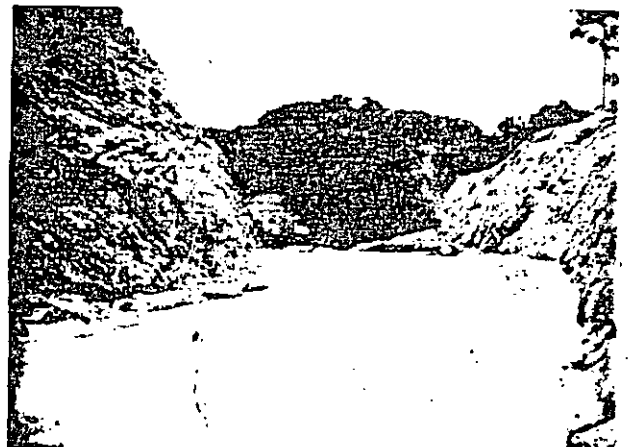
Cunetas revestidas en una formación susceptible de producir pequeños derrumbes que las obstruyan.
