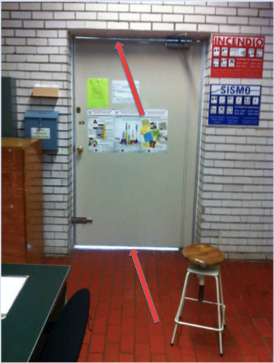
Figura 3.27 Puerta del laboratorio sin aislamiento acústico
