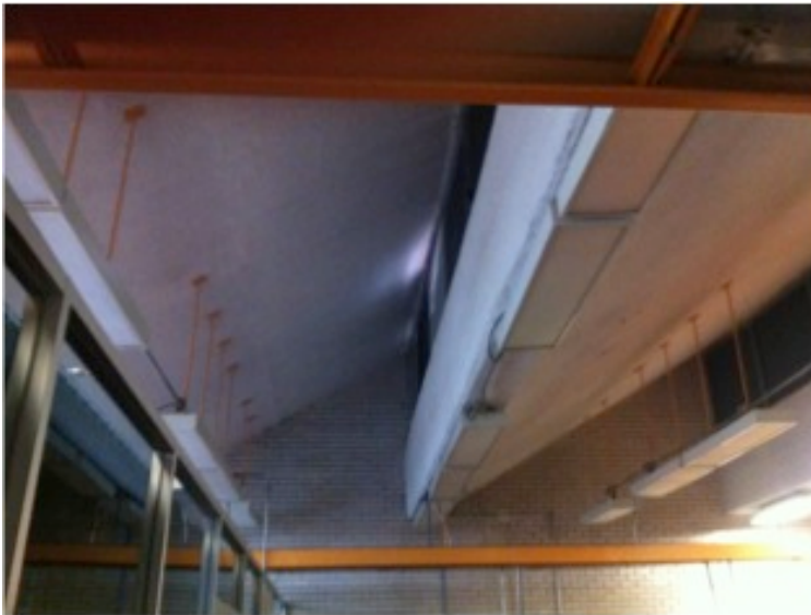
Figura 3.26 Techo del Laboratorio de forma irregular
