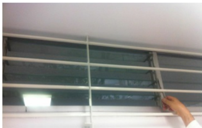
Figura 3.17 Ventanas del salón J110
