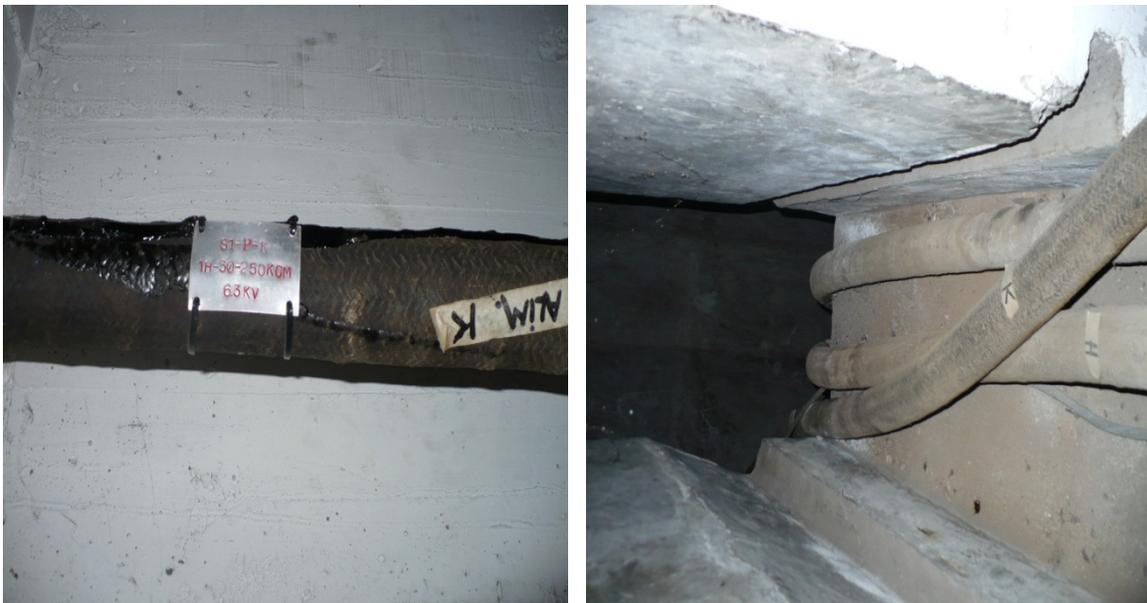
Debido al crecimiento y para la segunda subestación general construida en el campus de CU se utilizaron cables Monopolares con aislamiento EPR de 3 x 350 kCM los cuales alimentaban a 12 Subestaciones nuevas por el crecimiento en la universidad.
