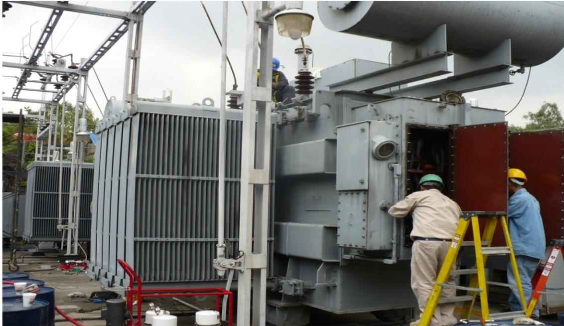
Para la General 2, hay 2 transformadores de 5 / 6.25 MVA, 23 / 6.6 kV, de igual forma uno se encuentra en operación y el otro en reserva para falla o mantenimiento.
