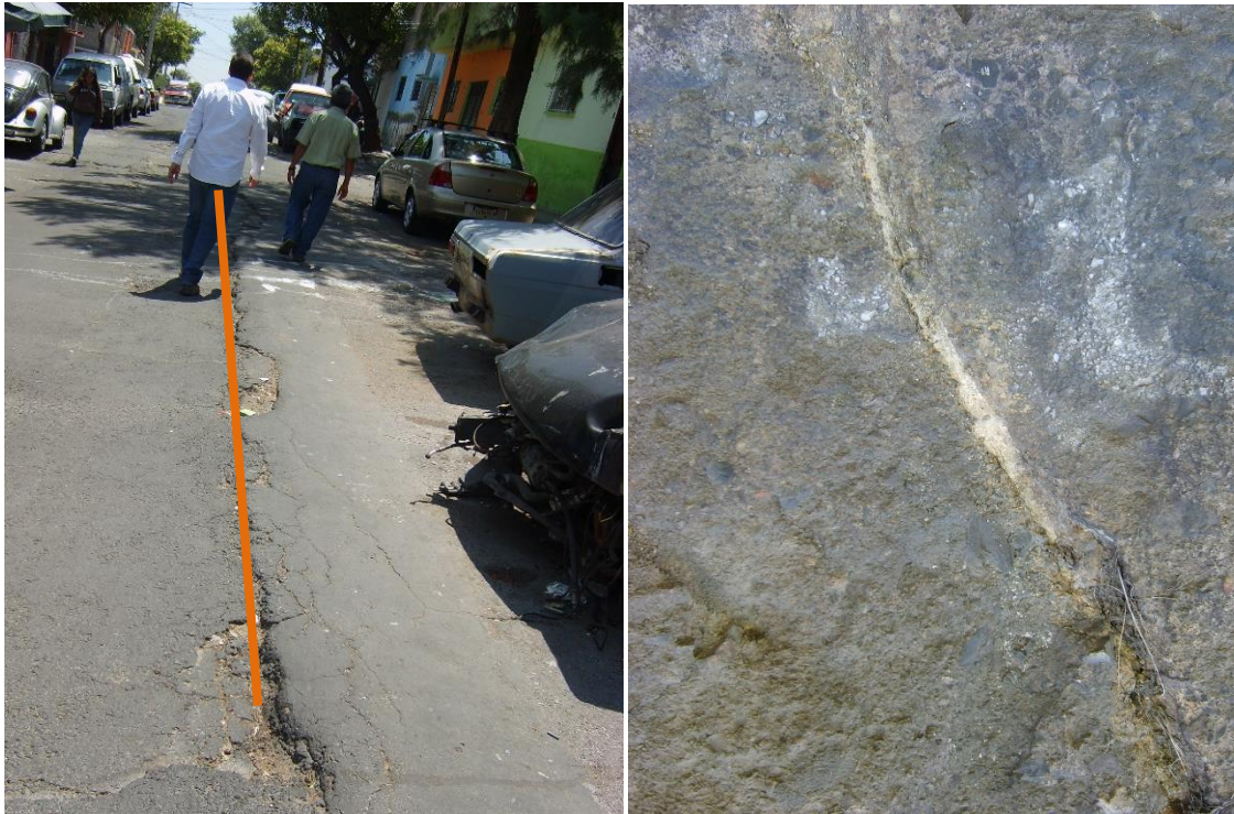
Fig. 41 y 42. Visita a la zona de estudio donde se observaron varias fracturas, algunas de estas rellenas de carbonatos.
