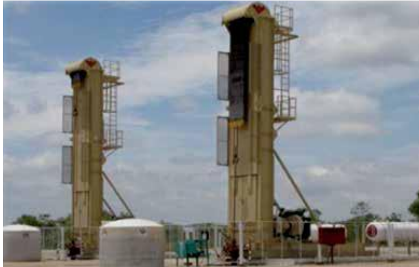
Figura 4.14 - Fotografía de la bombeo mecánico tipo Rotaflex utilizado durante la prueba piloto 1
