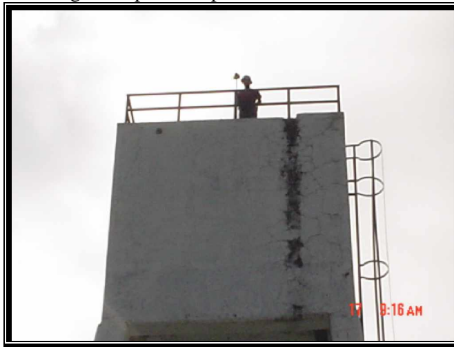
Fig. IV.9. Altura de tanque elevado.
