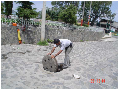
Figs. IV.3 y IV.4. Nivelación de pozos de visita.
