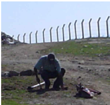
Fig. IV.8. Colocación de vértices.
