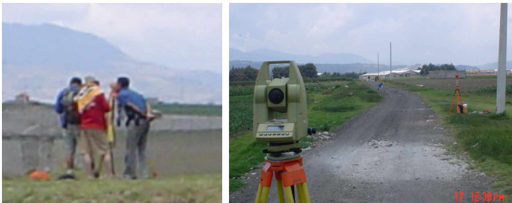
Fig. IV.6 y IV.7. Obtención y nivelación del eje de proyecto.
