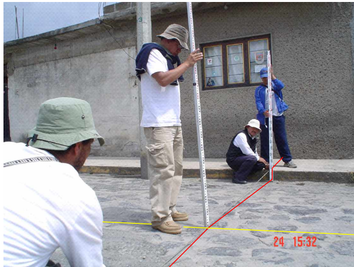
Fig. IV.5. Nivelación de sección transversal.
