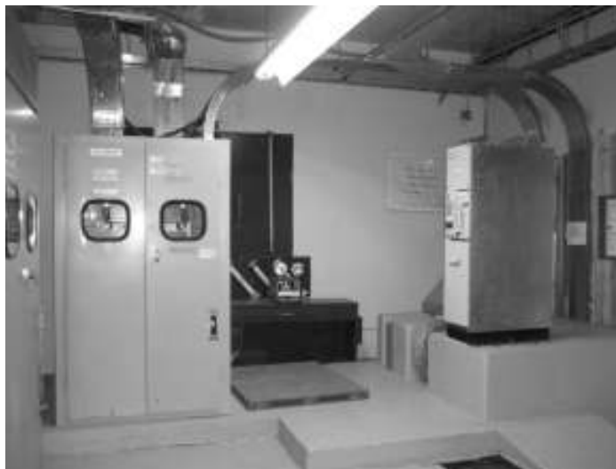
Figura 6.12. En la imagen se observan las dimensiones reales de una celda 8DH10 Siemens además de apreciarse la diferencia de tamaño con respecto una gabinete seccionador clásico aislado en aire (AIS).
