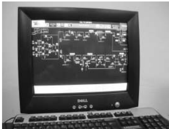
Figura 6.13. Pruebas del sistema de monitoreo del sistema eléctrico en anillo en 23kV.
