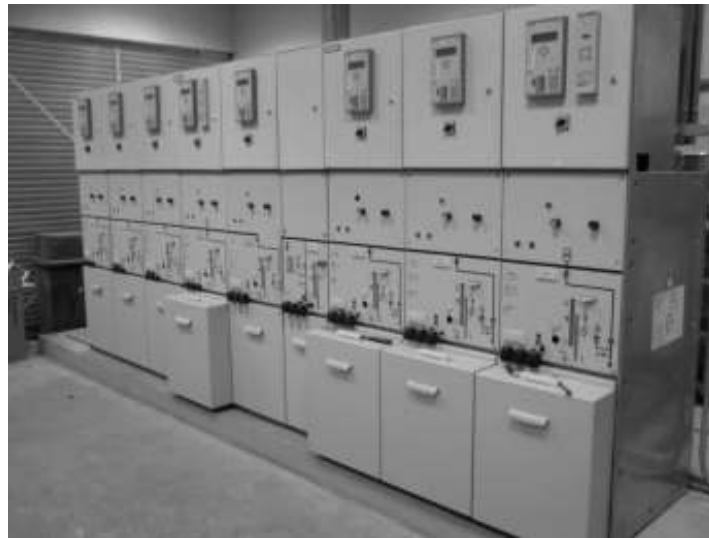
Figura 6.10. Pruebas finales del sistema en anillo.
