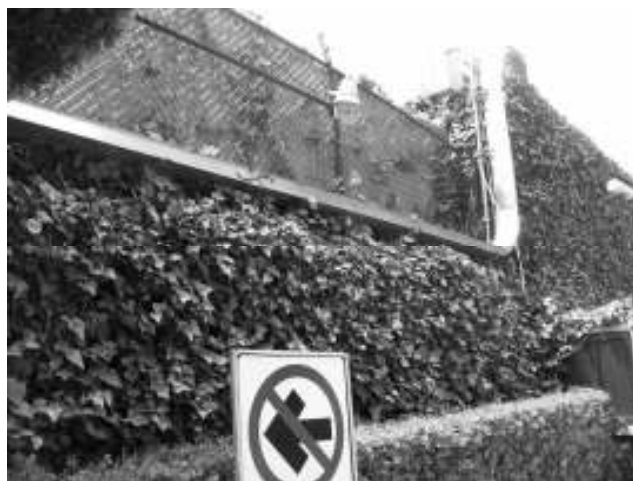
Figura 6.6. Ruta de charola de aluminio en aéreas con gran densidad de construcción.
