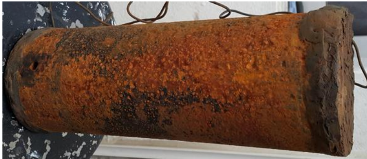
Fig. 57 Ducto después de la prueba a presión 1500 psi.
