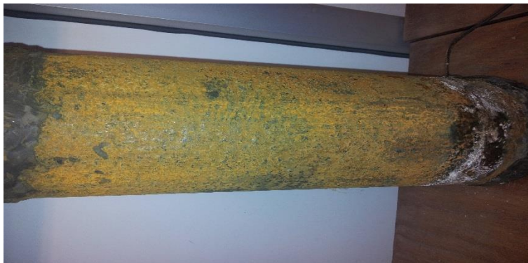
Fig. 54 Ducto después de la prueba a presión 250 psi.
