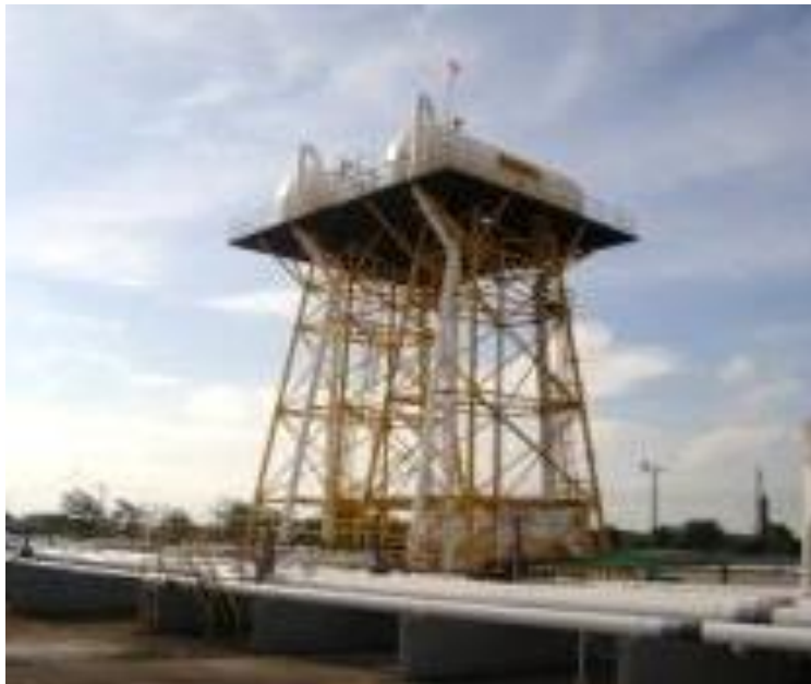
Figura III.1 Separadores elevados de baja/súper baja presión
