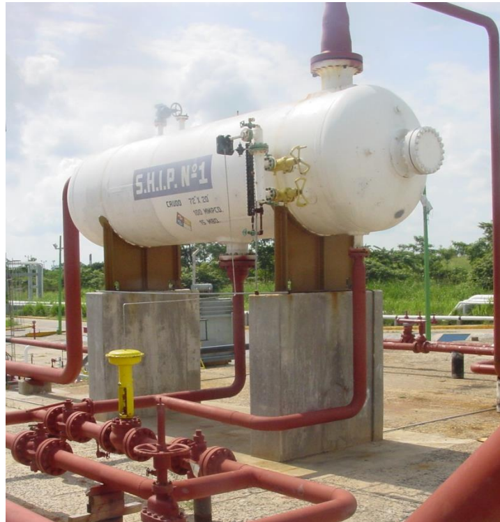
Figura II.1 Separador trifásico horizontal
