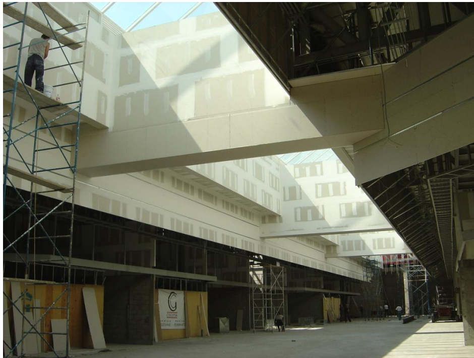
Figura 25 Colocación de paneles de yeso en faldones y plafones falsos de áreas comunes, previo a la aplicación de pintura vinílica.
