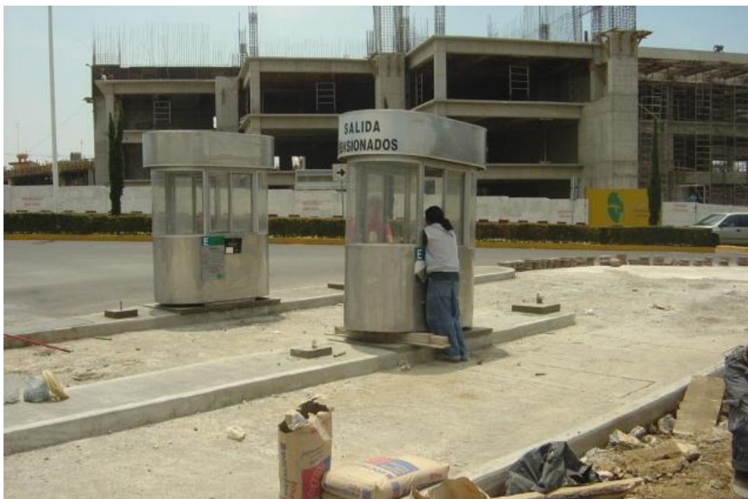
Figura 21 Reubicación de casetas entrada y salida durante proceso de obra.
