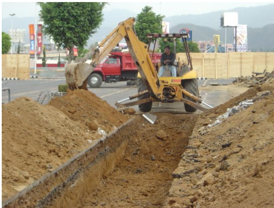
Figura 17 Trabajos de excavación de cepas de cimentación en estacionamiento.
