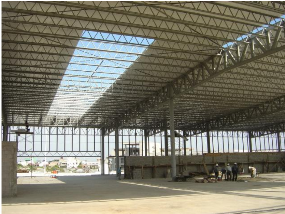
Figura 33 Corte en cubierta para creación de lucernario visto desde el interior de la tienda.
