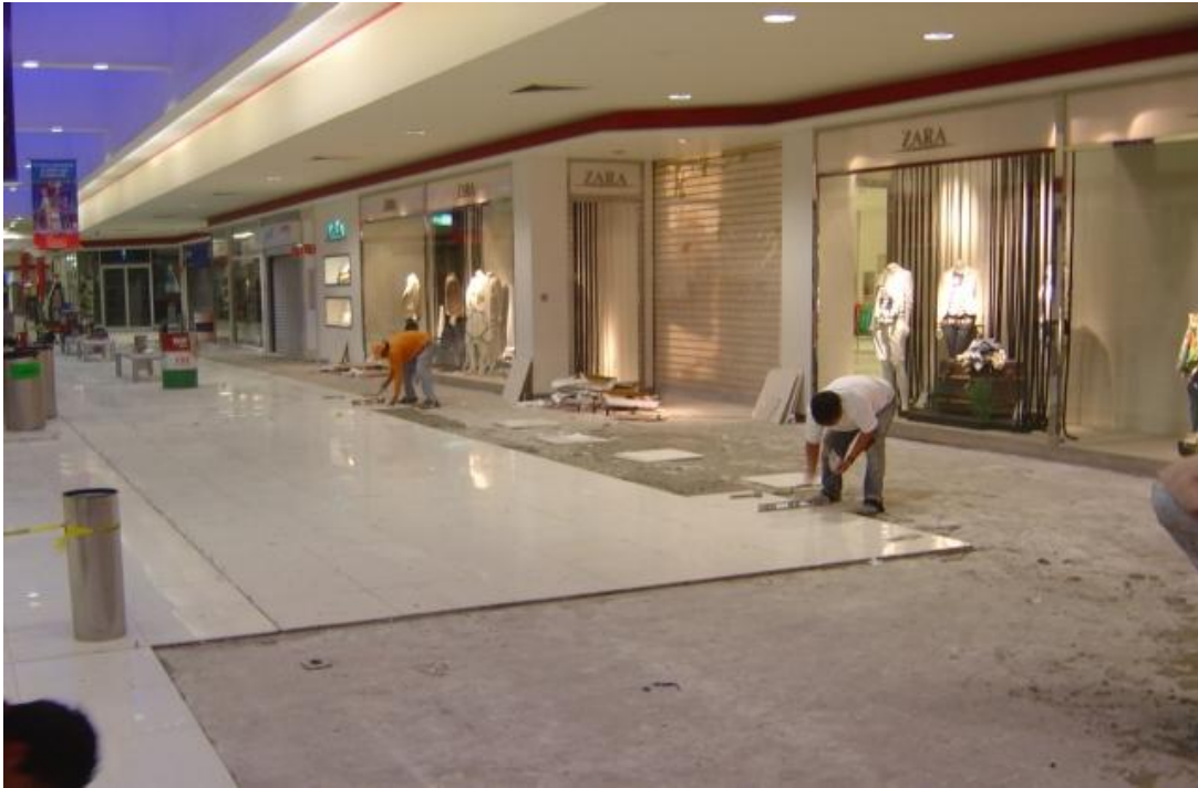
Figura 26 Colocación de piso de porcelanato en área de pasillo de tiendas, previa demolición de acabado anterior.
