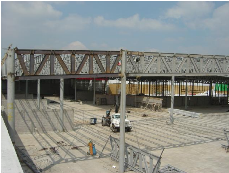
Figura 28 Colocación de estructura metálica en nave durante el proceso de fabricación.
