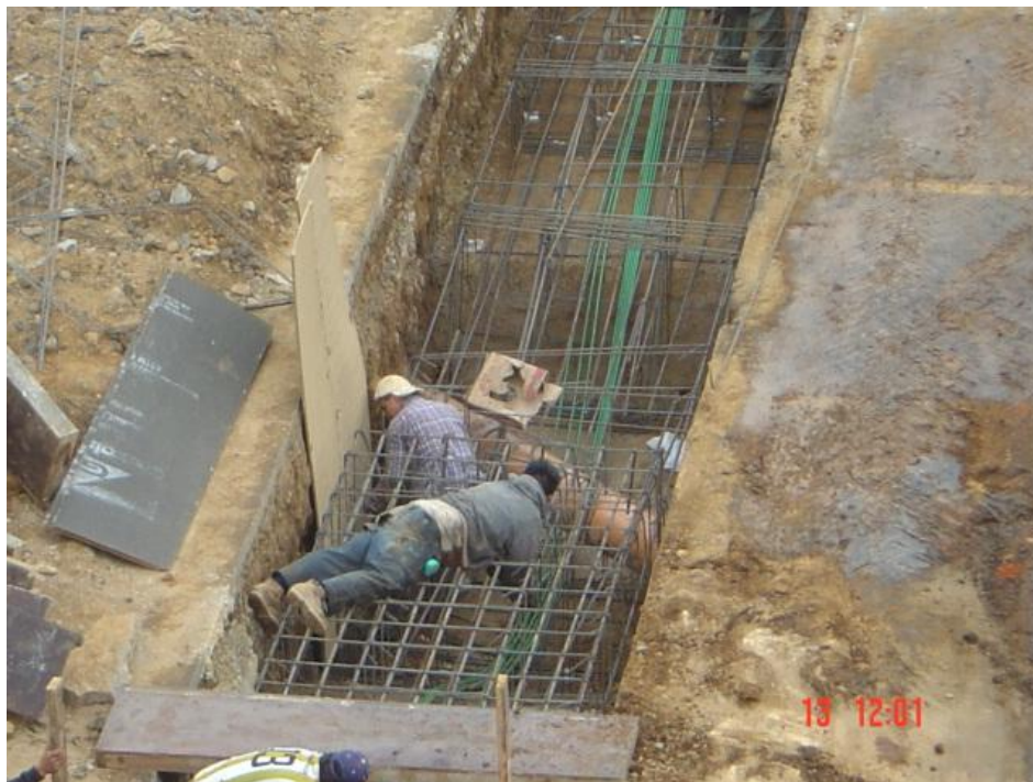
Figura 19. Colocación de cable de presfuerzo en cimentación.
