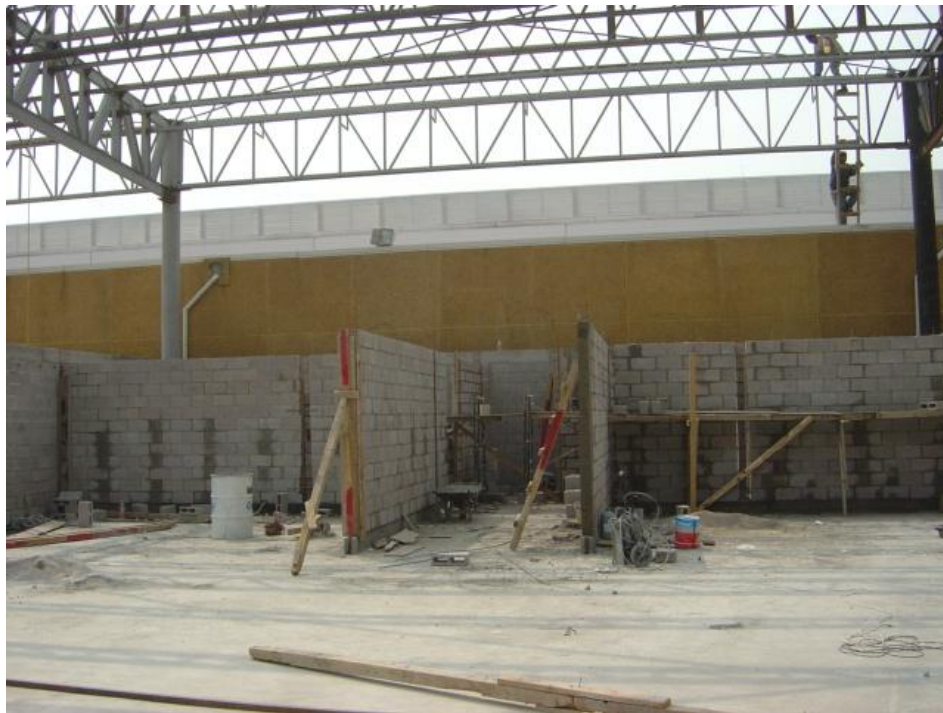
Figura 24 Construcción de muros de block para división de locales comerciales.
