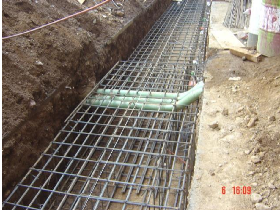
Figura 18 Colocación de acero de refuerzo en cepa de cimentación.
