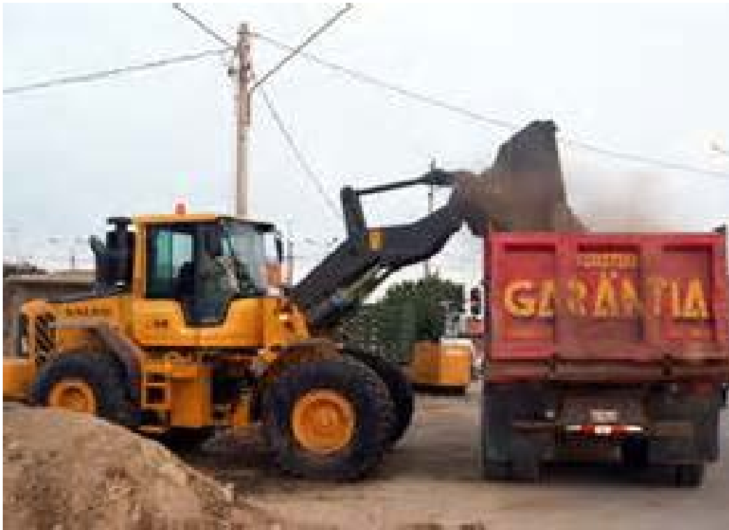
Foto No. 11 Carga de camión para retiro de material excavado
