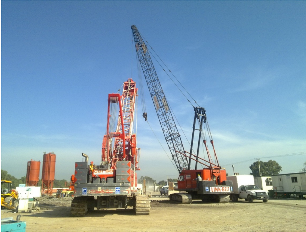
Foto No. 6 Maniobras de grúas para excavación
