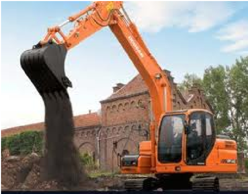
Foto No. 9 Proceso de excavación con retroexcavadora
