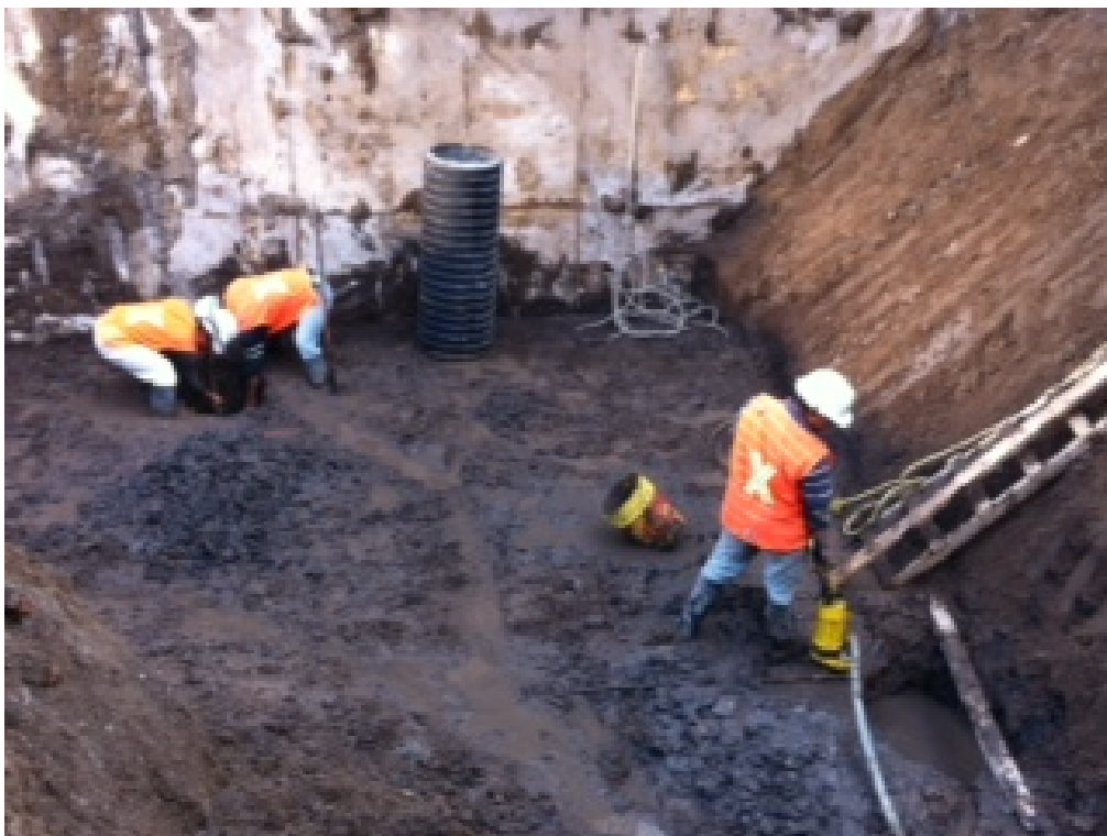
Foto No. 1 Pozo de alivio y bombeo de achique
