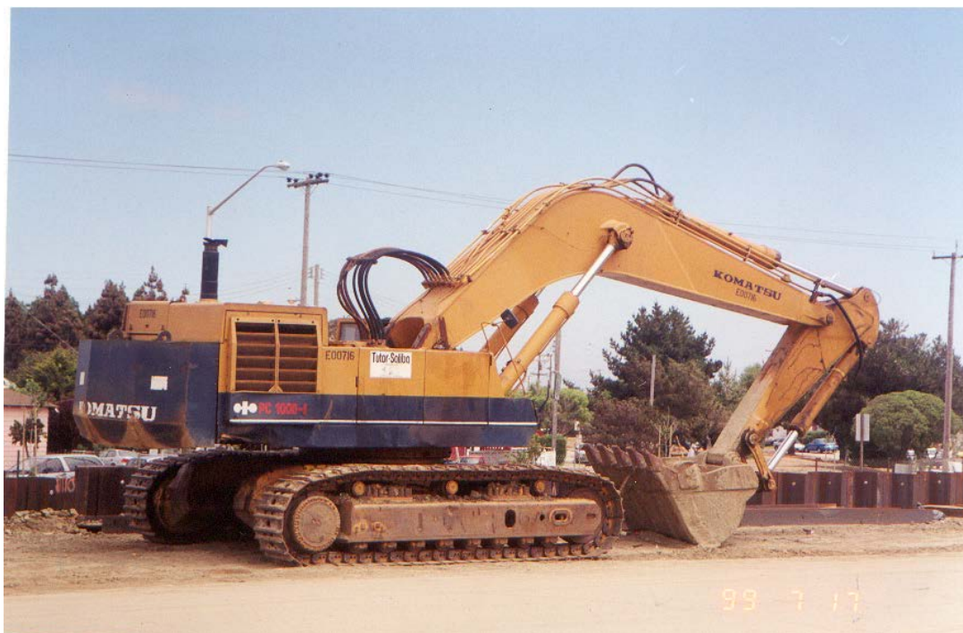
Foto No. 8 retroexcavadora sobre orugas
