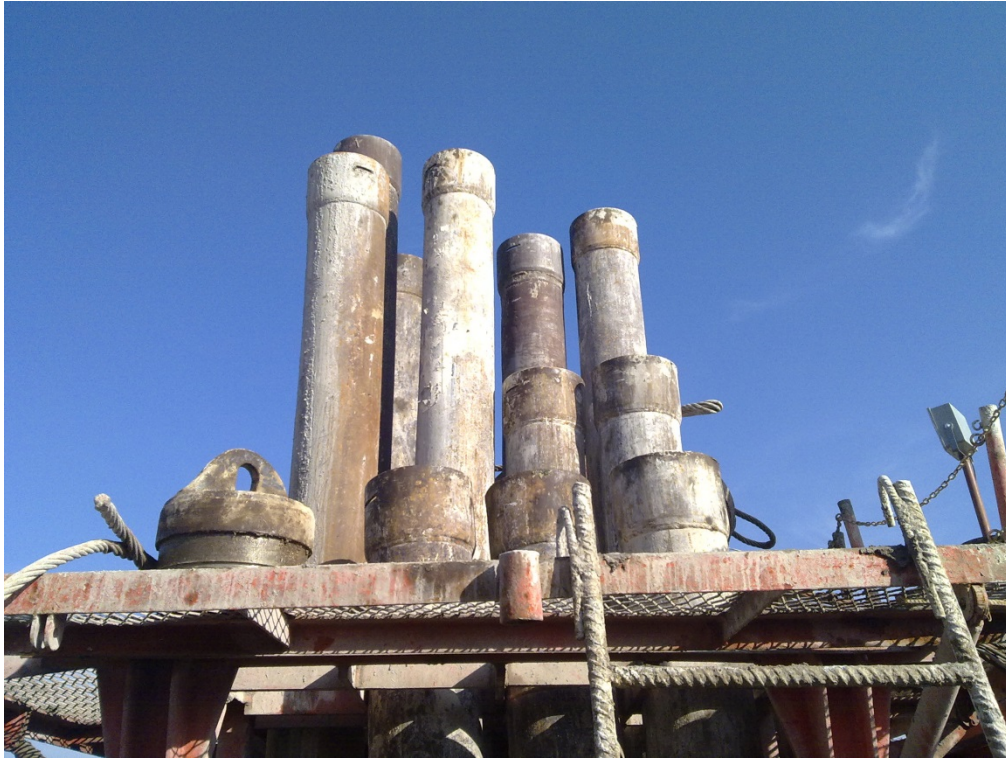
Foto No.3 tubería tremie
