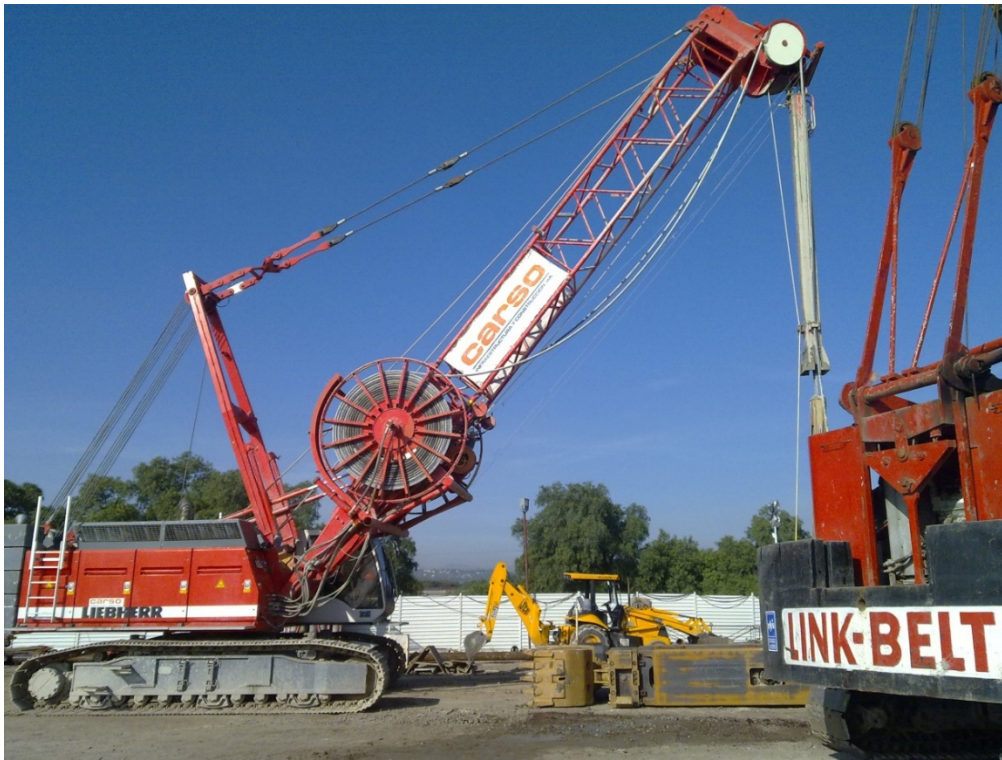
Foto No. 5 Grúa para izar de tubería
