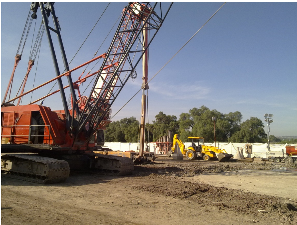
Foto No.4 Grúa para insertar tubería Tremie
