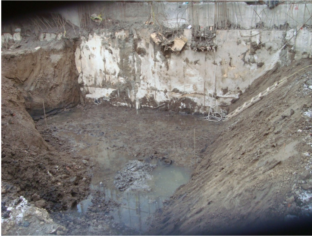
Foto No. 7 Protección de linderos mediante muro milán
