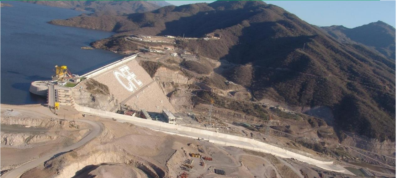
Figura 2-1 Presa El Cajón en México, con una altura de 189 m (2x375 MW Turbina tipo Francis)
