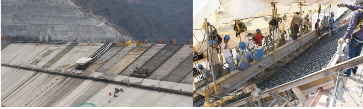
Figura 5-61 Losas de Cara de Concreto (cimbra deslizante)
