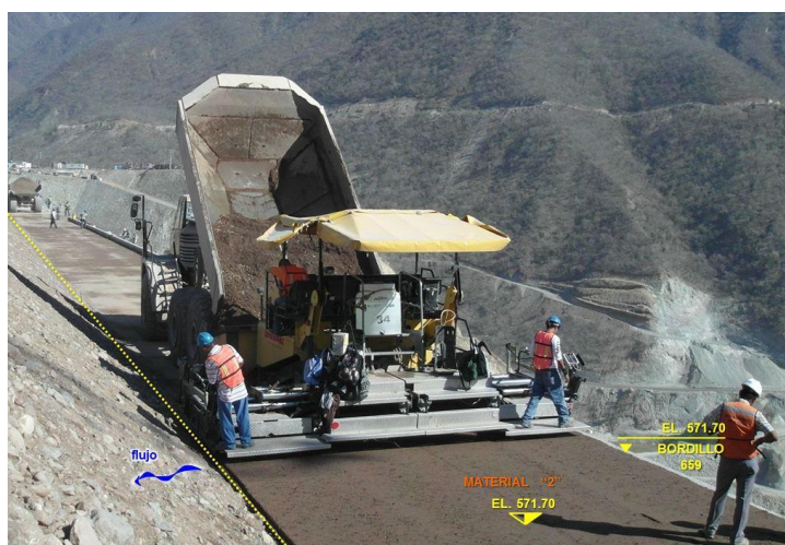
Figura 5-67 Colocación de Material 2
