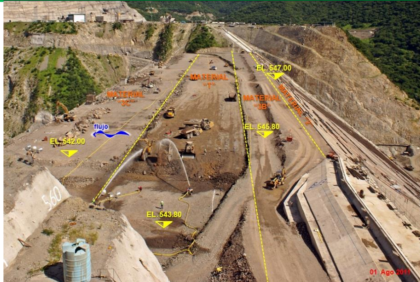
Figura 4-6 Arreglo del enrocamiento colocado y compactado en la construcción de la Presa La Yesca
