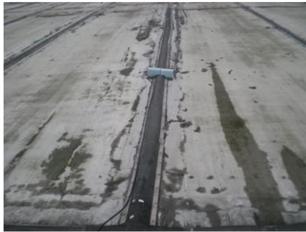
Figura 6-2 Cara de Concreto después de la reparación de la presa Zipingpu ECCC (Fotografía cortesía ZepingXu, China) Tomadas de la presentación del Dr. Martin Wieland en el "The First International Symposium on Rockfill Dams", en Chengdu, China del 18 -21 de octubre 2009
