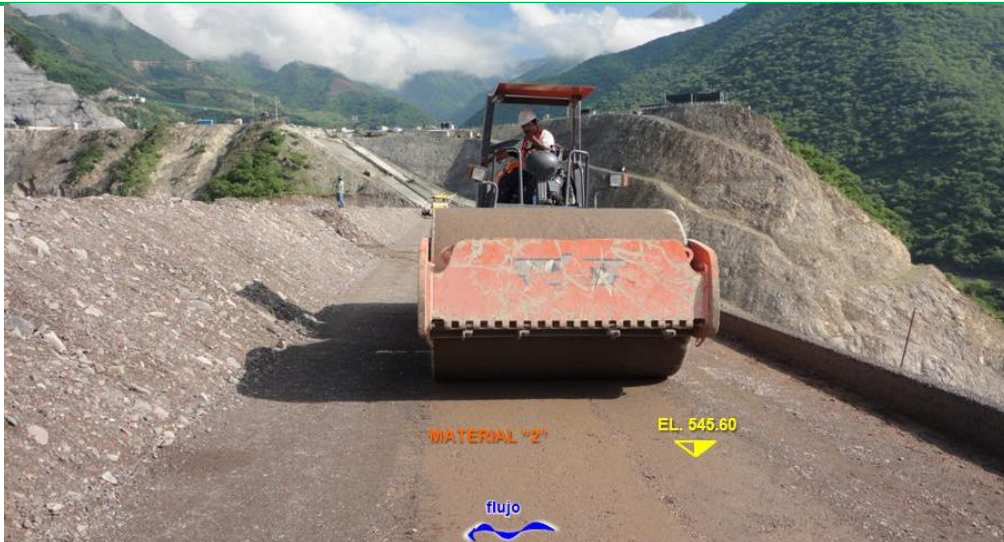
Figura 4-3 Compactación de la Zona 2 (Presa La Yesca, México)
