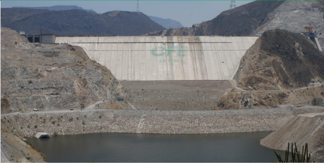
Figura 2-3 Presa La Yesca en México, con una altura de 208.5 m (2x375 MW Turbina tipo Francis)
