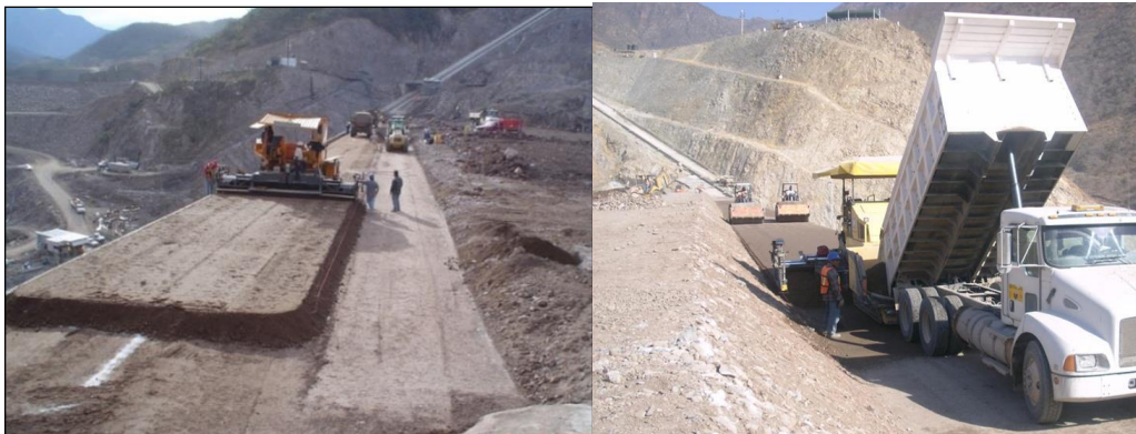
Figura A-7 Colocación del material en la Zona 2
