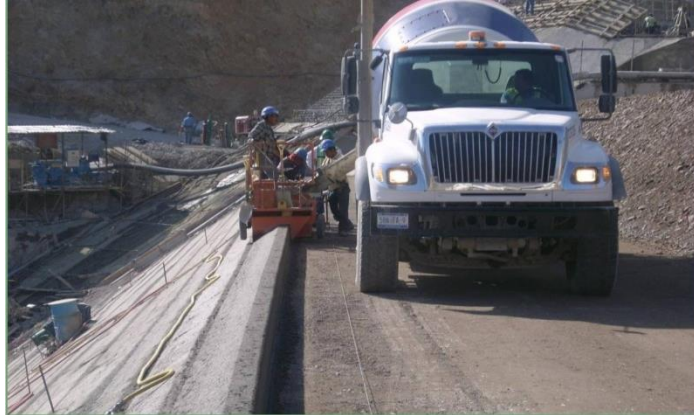
Figura 4-4 Construcción de bordillo en la presa La Yesca
