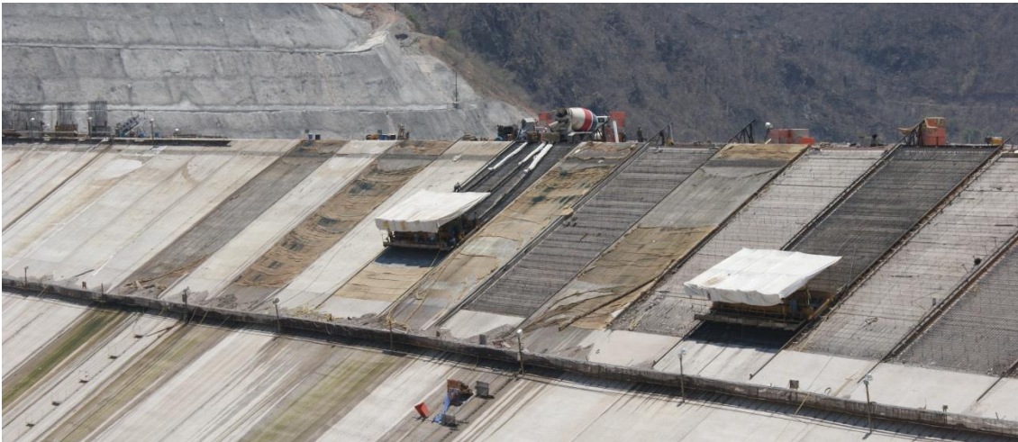
Figura 4-20 Cimbra deslizante utilizada en la presa La Yesca
