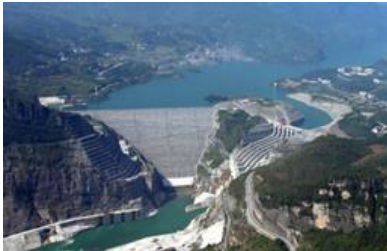
Figura 2-2 Presa Shuibuya en China, con una altura de 233 m (4x460 MW Turbina tipo Francis)
