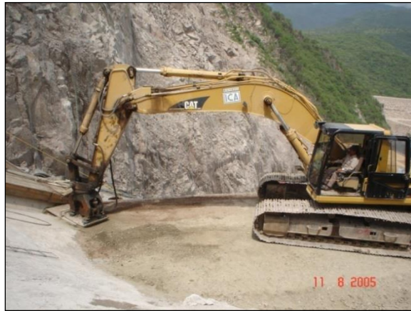
Figura A-8 Colocación del material en la Zona 2F
