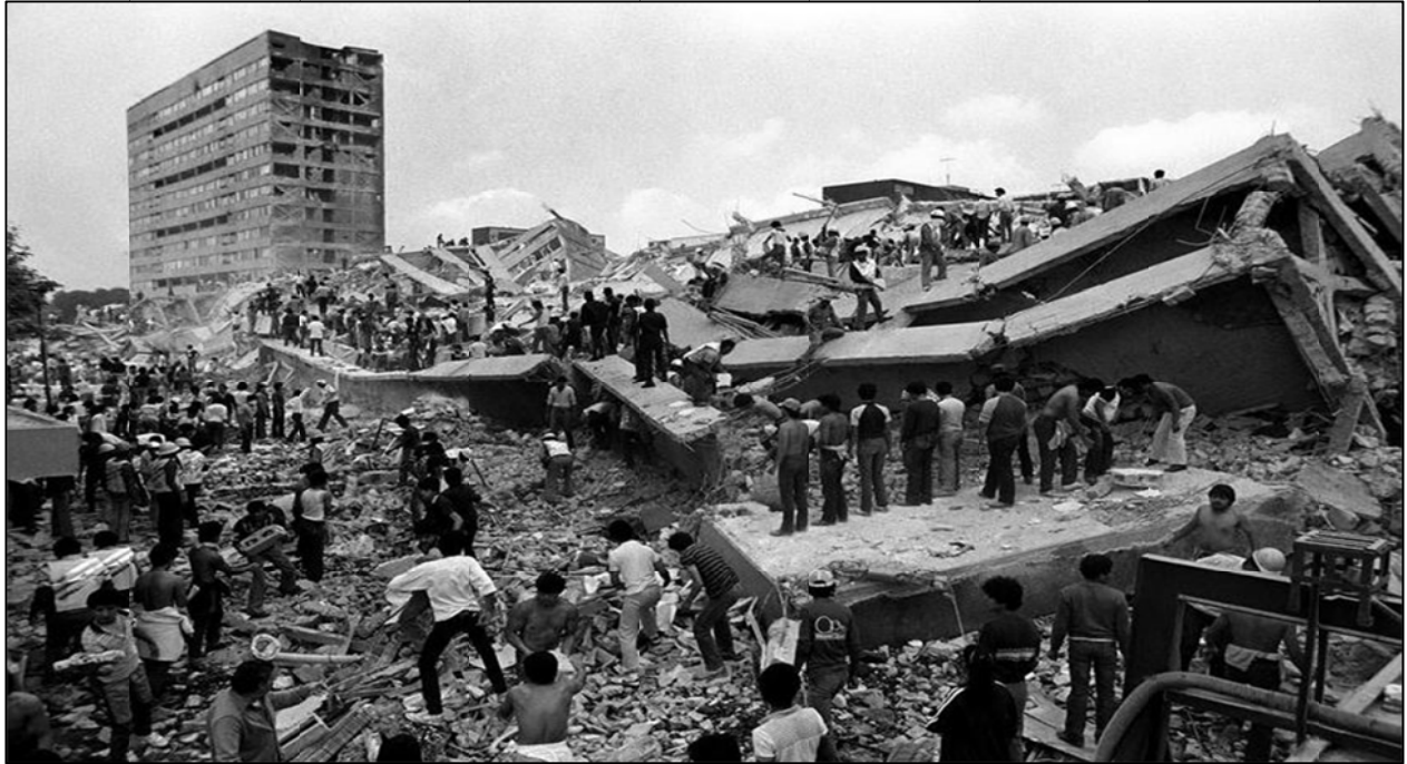
Imagen 1.7. Colapso de inmuebles como consecuencia del sismo del 19 de Septiembre de 1985.
