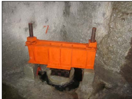
FIG. 1.3 SISTEMA DE PILOTES DE CONTROL VISTA LONGITUDINAL 1
