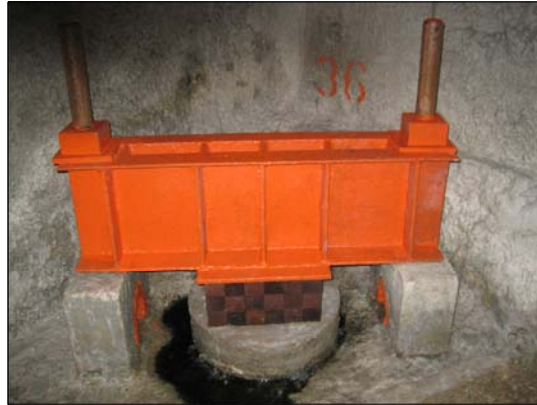
FIG. 1.4 SISTEMA DE PILOTES DE CONTROL VISTA LONGITUDINAL 2
