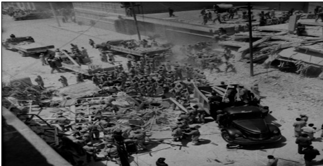
Imagen 1.5. Derrumbe de inmuebles en la Ciudad de México tras el sismo de 1957.
