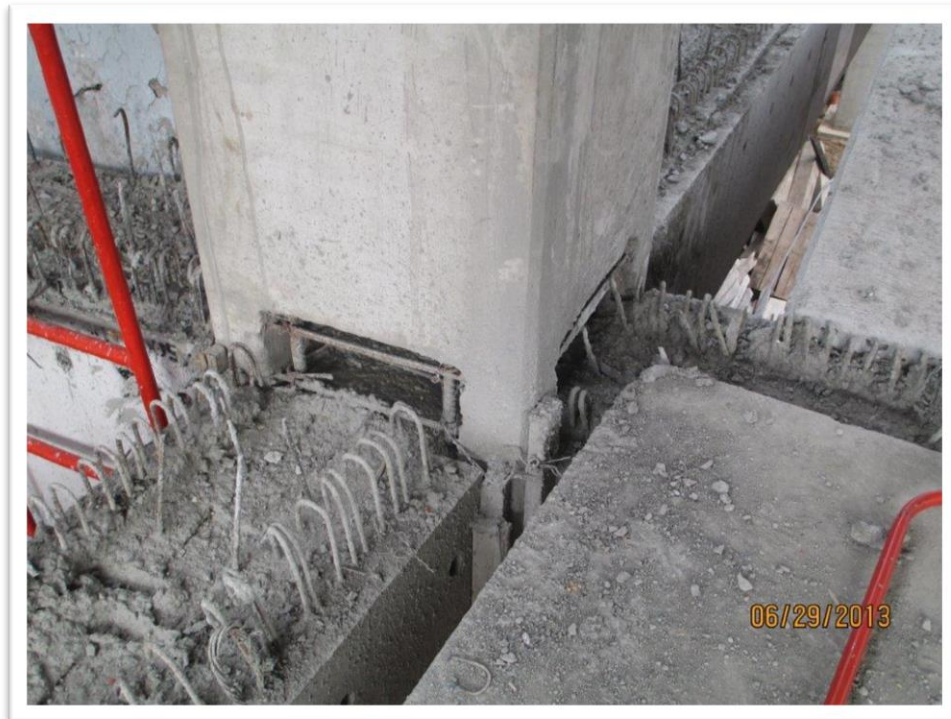
Figura 4.58. En esta imagen se observa el "nudo" ya colado, los huecos que se observan en una segunda etapa junto con el firme de compresión.
