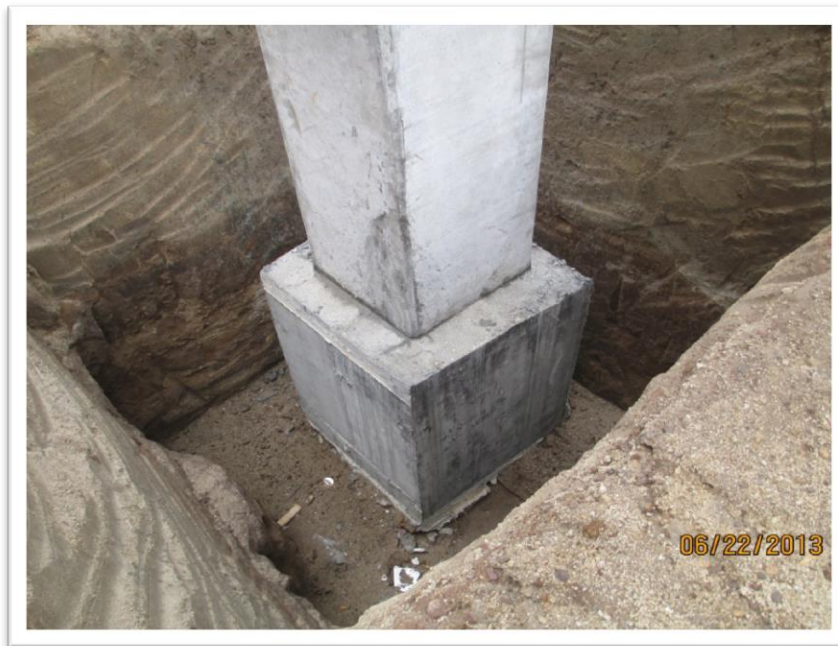
Figura 2.6. Dado de conexión ya colado. Proyecto: estacionamiento Anáhuac.
