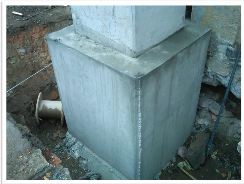
Figura 4.39. Una vez alineada la columna verticalmente se procede al colado de su conexión con la cimentación.
