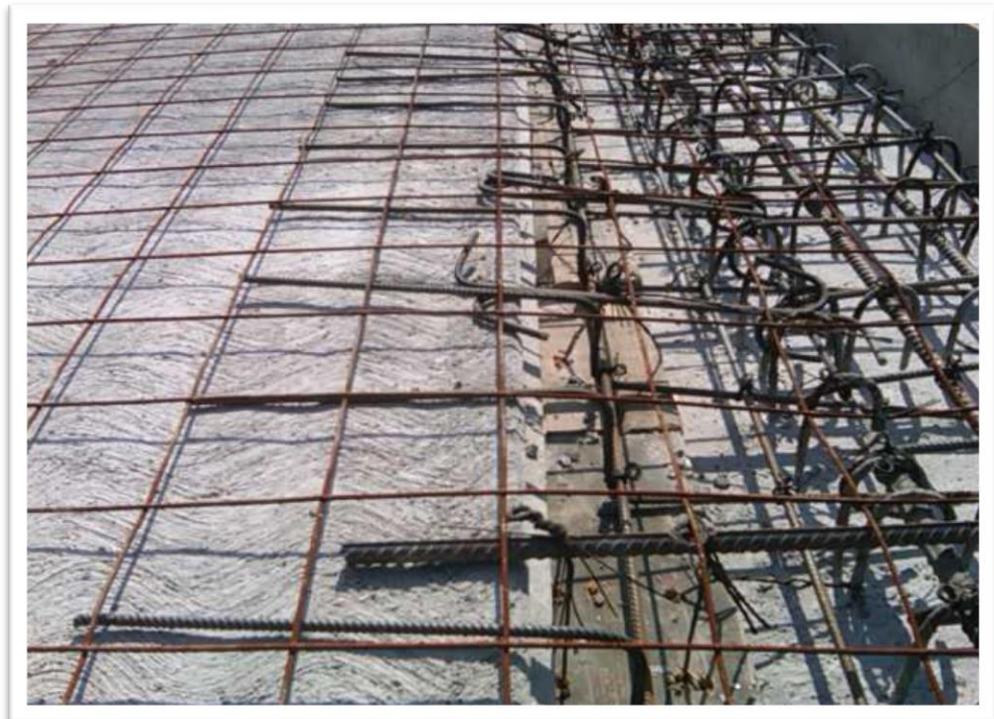
Figura 4.64. Imagen de otro colado de ajuste ya cimbrado. El colado se realiza monolíticamente con el firme de compresión.
