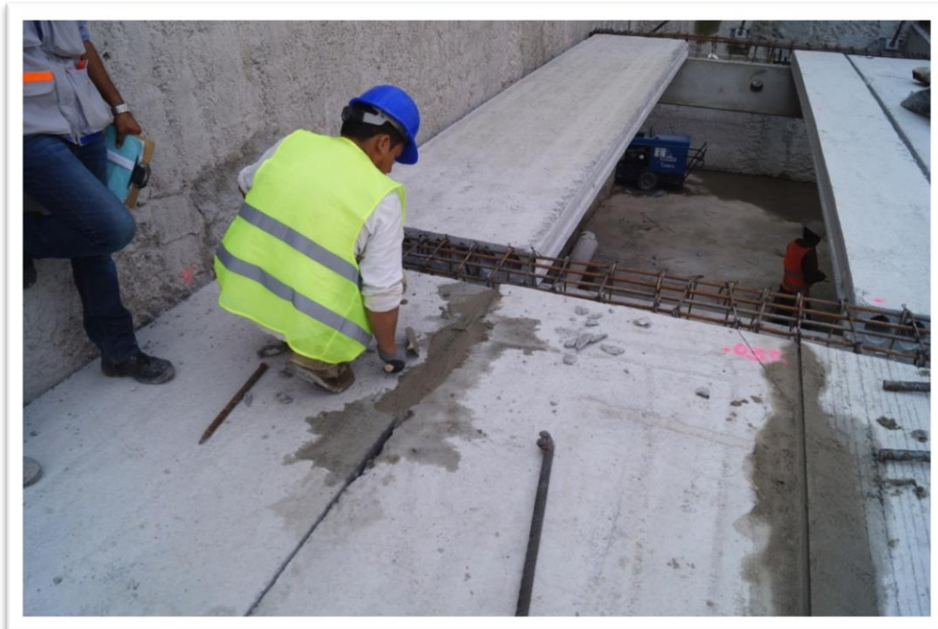
Figura 4.61. Una vez colocadas las losas alveolares en su posición final se realizan los trabajos de junteo (que no es otra cosa que el relleno de las llaves de cortante con mortero cemento-arena).
