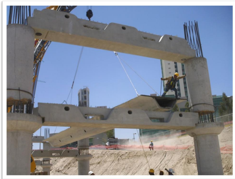
Fig. 2.37. En esta imagen se observan las traves tipo TPOM y el montaje de losa tipo Omega.
