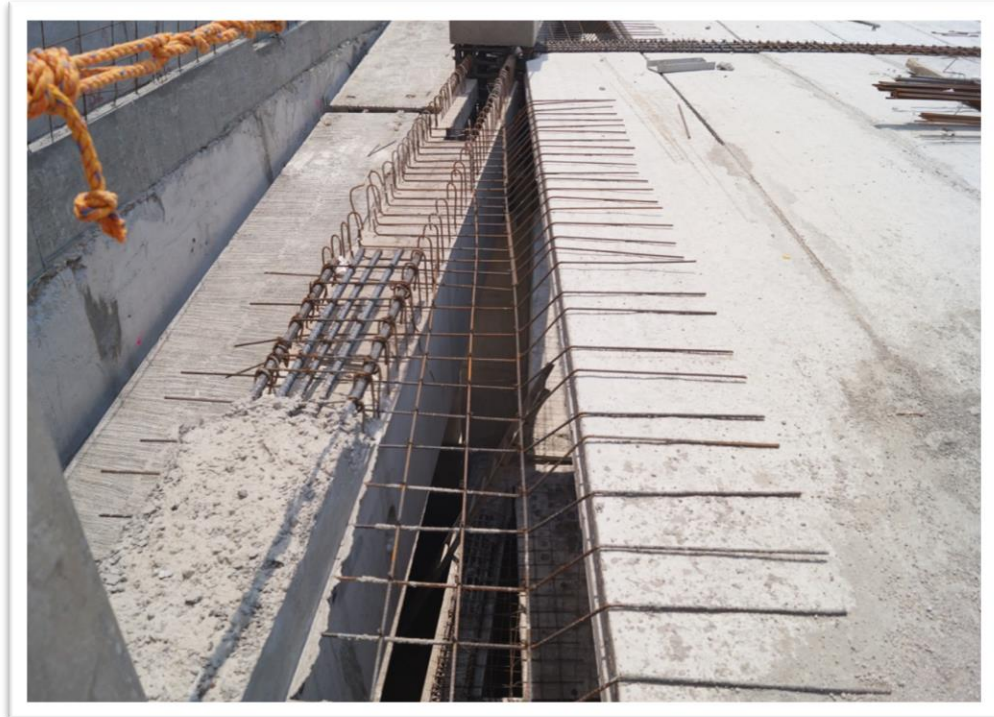
Figura 4.63. En esta imagen se observan los trabajos de armado del acero de refuerzo en las zonas que por su geometría no se alcanzan a cubrir con losa alveolar (colados de ajuste).
