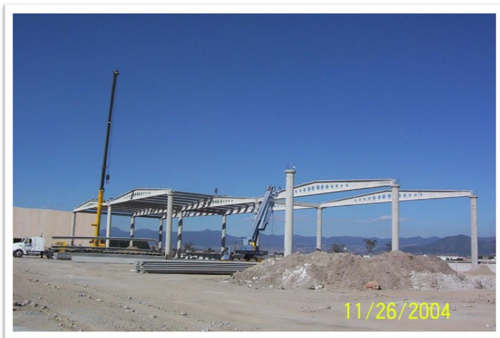
Figura 2.27. Nave industrial "Lerma" en el Estado de México, trabajos de montaje de columnas y traveses tipo Delta de 32 m de longitud.
