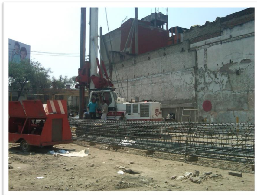
Figura 4.18. Trabajos de perforación de pila. Proyecto: taller Soni Revolución.
