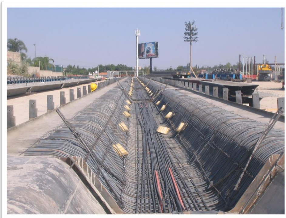
Fig. 2.38. En esta imagen se observa la línea de producción para las losas Omega. En este proyecto (centro comercial Andares) se implementó una planta de prefabricados “in situ” para optimizar el costo final de la estructura.
