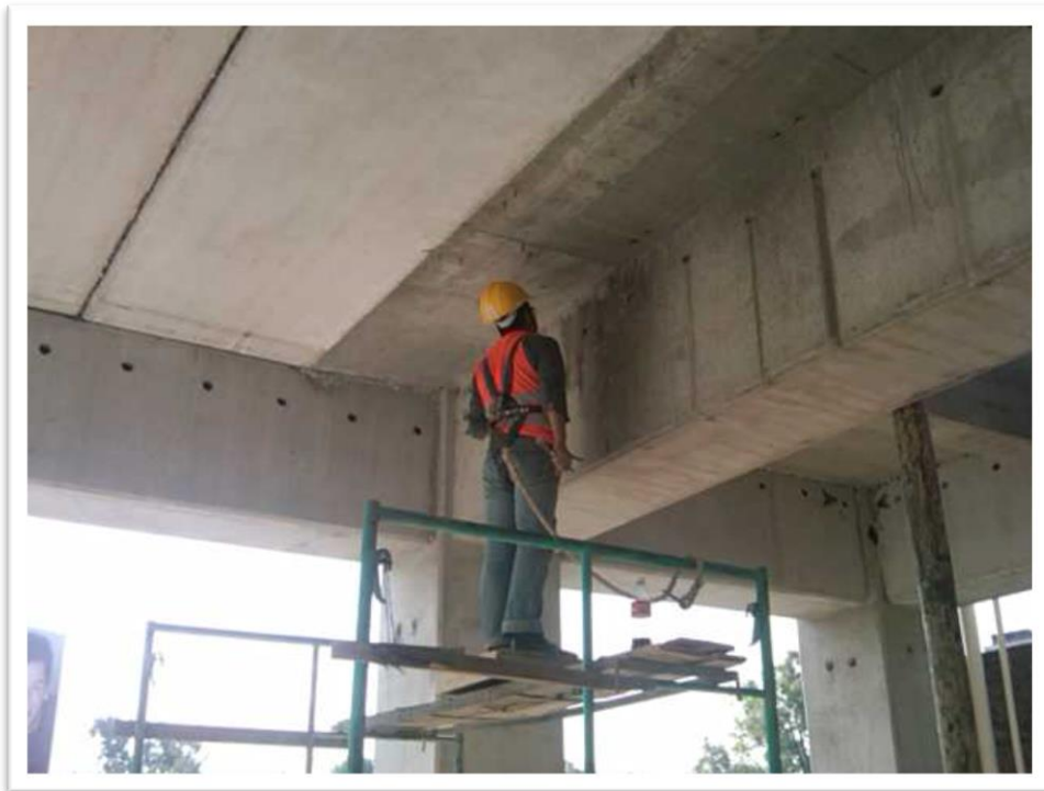
Figura 4.68. Por último, se realiza el acabado en los elementos prefabricados y la limpieza general de toda la obra.
