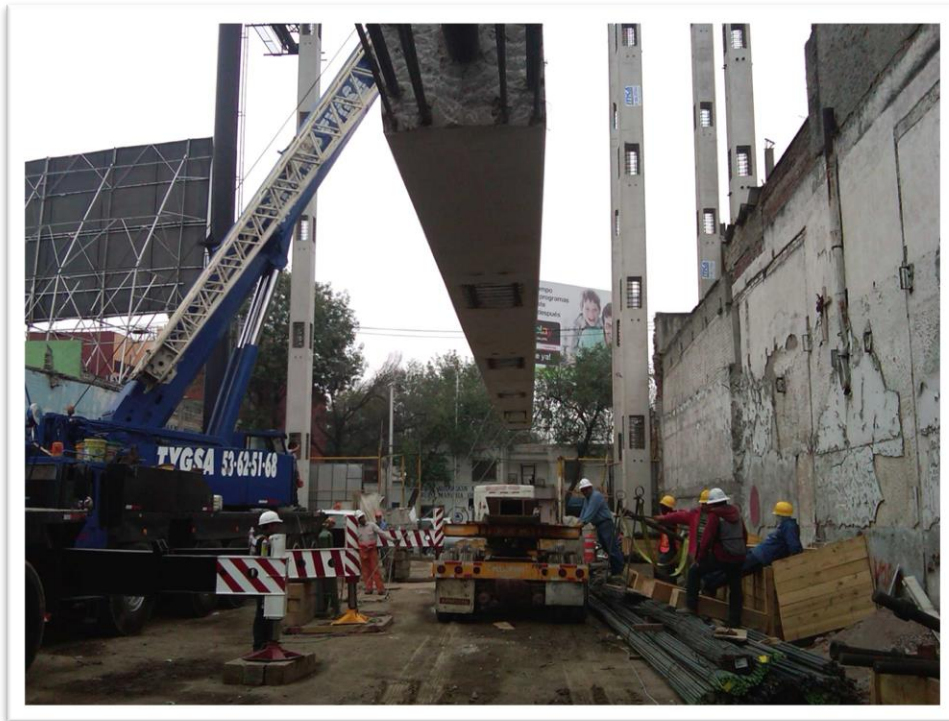
Figura 4.35. Una vez izada la columna es recomendable retirar el equipo de transporte para poder bajar la columna a piso e insertar el perno de izaje en la cabeza de la misma.
