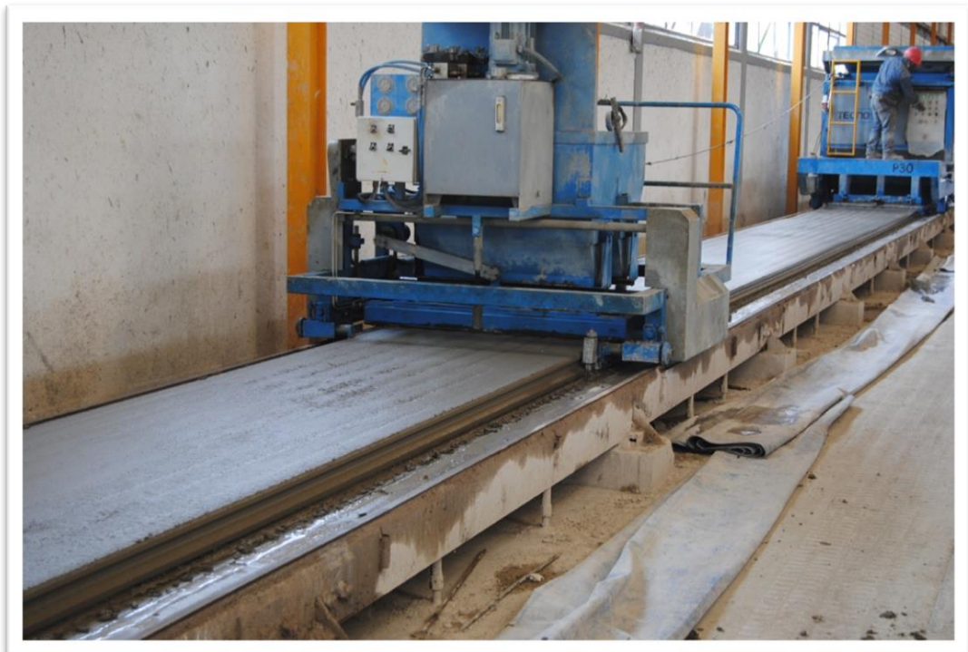
Figuras 4.16 y 4.17. Una vez ajustado el presfuerzo la maquina extrusora cuela toda la longitud de la cama (en este caso 200 m), al final se realizan los cortes en la losa para obtener losas de las dimensiones requeridas.
