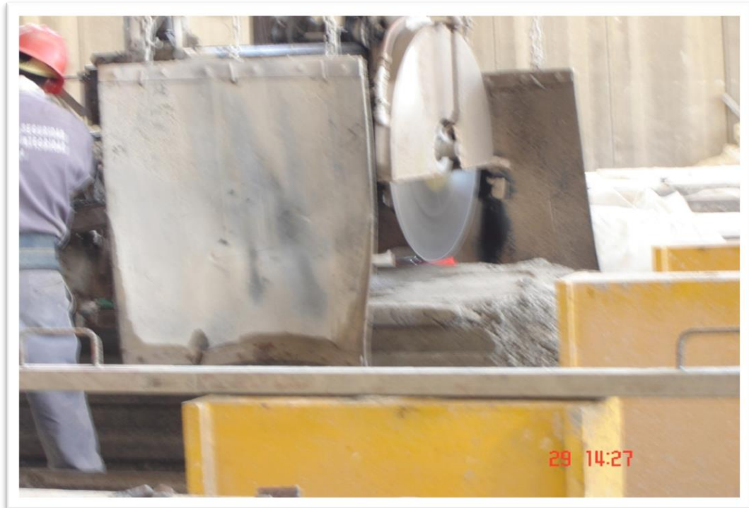
Figura 4.18. Una vez alcanzado el fraguado se realizan los cortes para obtener las longitudes requeridas de proyecto.
