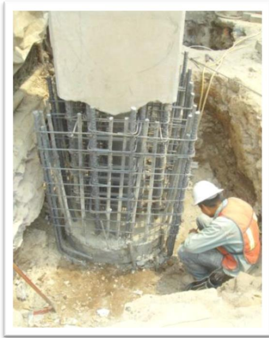
Figura 4.47. Trabajos de armado complementario entre dado y columna prefabricada.
