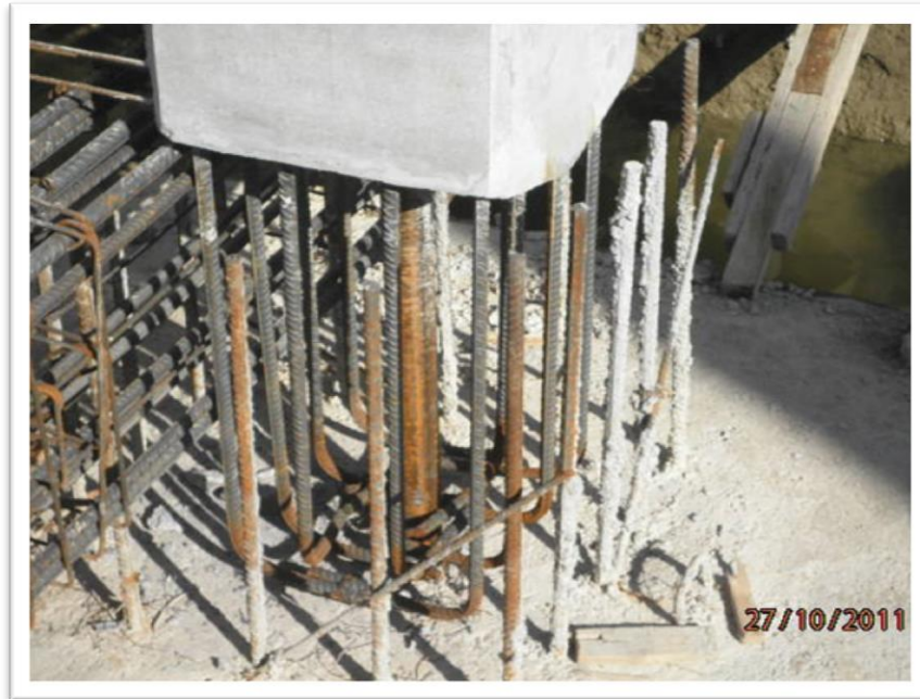
Figura 2.5. Preparación en cimentación para la fabricación del dado de conexión con la columna. Proyecto Centro Integral de Servicios Puebla.
