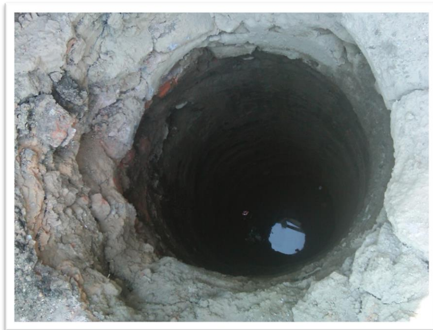
Figura 4.19. Perforación realizado de 1.30 m de diámetro y 15.50 m de profundidad.
