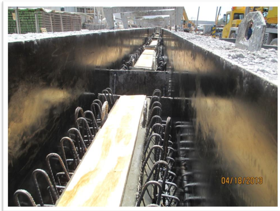
Figura 4.13. Una vez realizados los trabajos de tensado de los torones ya se pueden colocar los costados y tapas.
