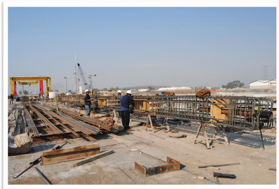
Figura 4.3. Incluso antes de tener la línea de fabricación habilitada se puede dar inicio a los trabajos de habilitado y armado de acero de refuerzo y adecuación de nodos abiertos (cimbra) de la columna, se recomienda que estos trabajos se realicen a un costado de la línea para evitar el traspaleo del armado.
