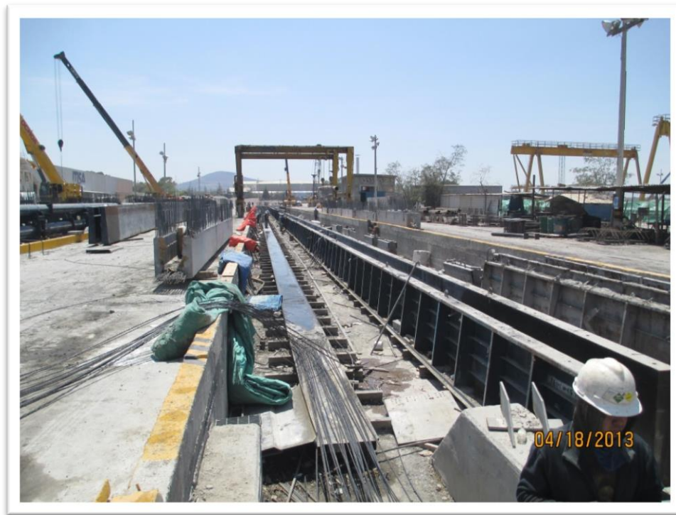
Figura 4.6. Para el colado de las traveses se cuenta en planta con un foso de 120 m de longitud y tres líneas con el fondo listo para recibir los costados y ajustar estos últimos de acuerdo a la sección de las traveses.
