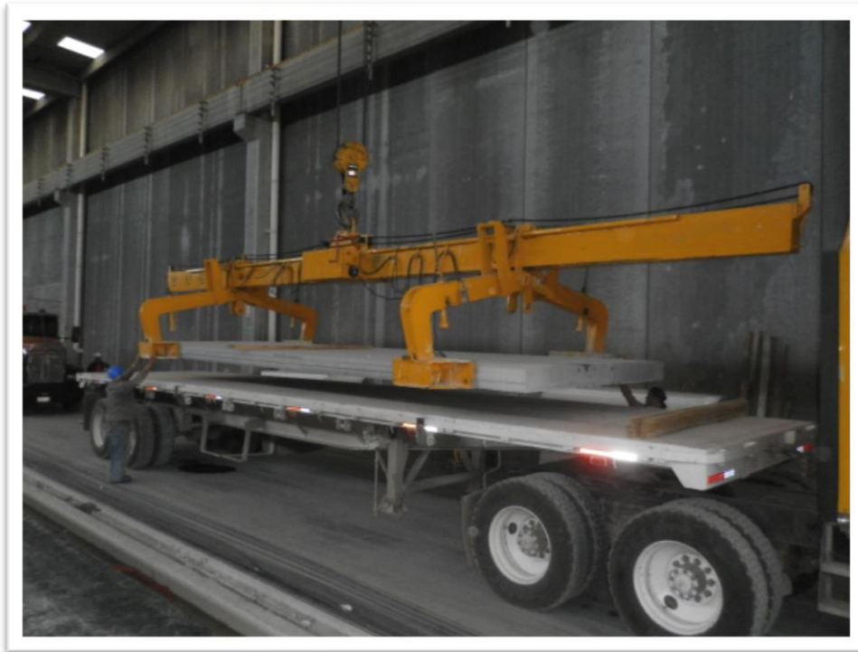
Figura 4.26. Embarque de losas alveolares en nave de producción planta Tecámac. Proyecto: Taller Soni Revolución.
