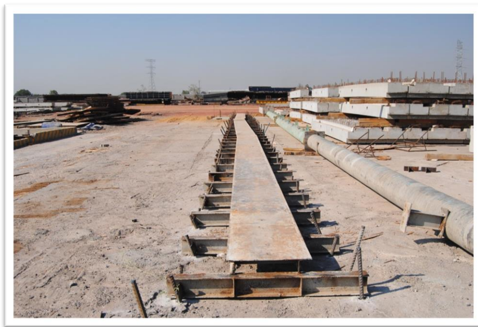
Fig. 4.1. En esta imagen se observa el inicio de habilitado de línea para fabricación de columnas. En el caso de este proyecto las columnas miden 28.00 m por lo que se habilito una sola línea de 30.00 m.
