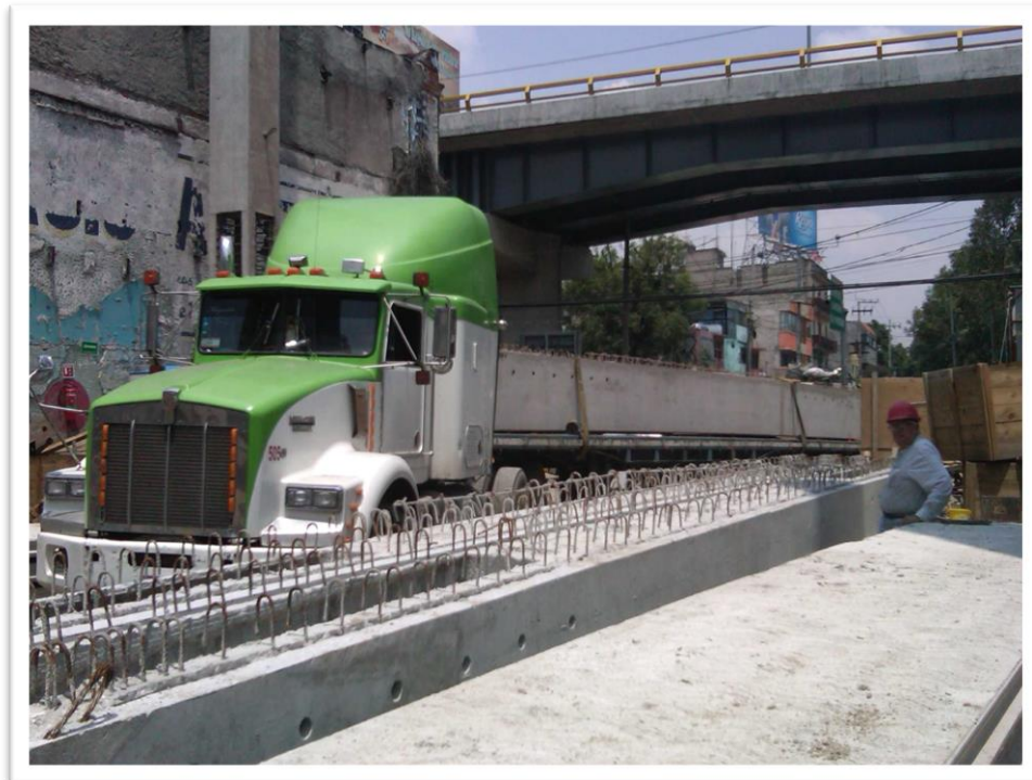
Figuras 4.28 y 4.29. Transporte de traves en carga tipo plataforma regular de 2.40 m x 12.00 m. Proyecto: Taller Soni Revolución.
