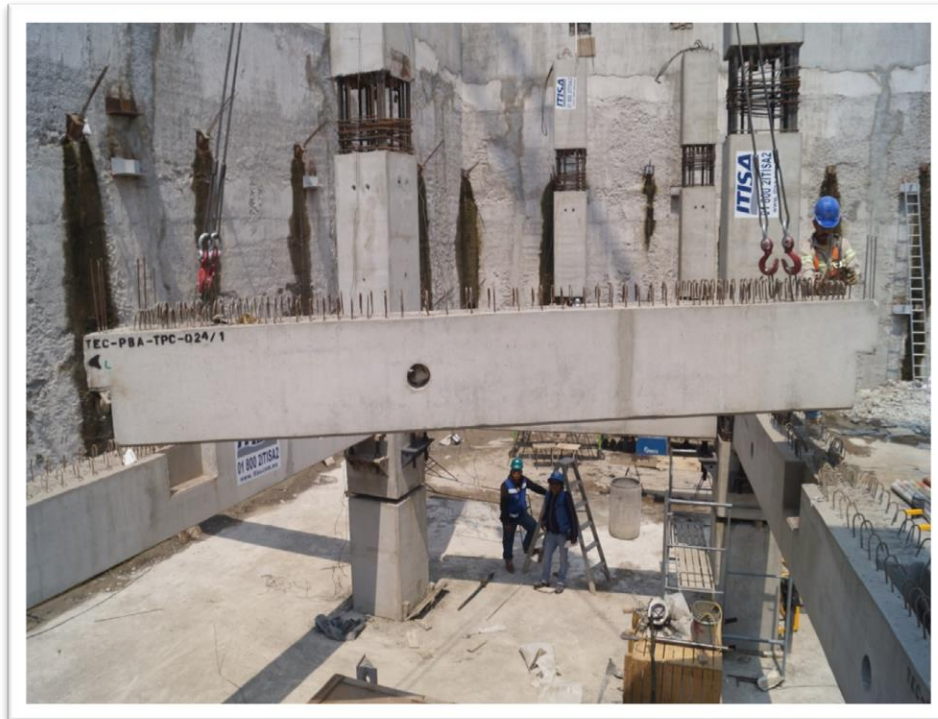
Figura 2.53. Trabajos de montaje de traveses secundarios tipo TPC para reducir el claro del tablero. Proyecto: Centro comercial Azcapotzalco Ciudad de México (2014).
