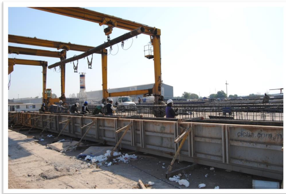
Figura 4.2. La siguiente etapa consiste en fijar los costados del molde de acuerdo a la sección de la columna, en este caso es de 80 x 80.
