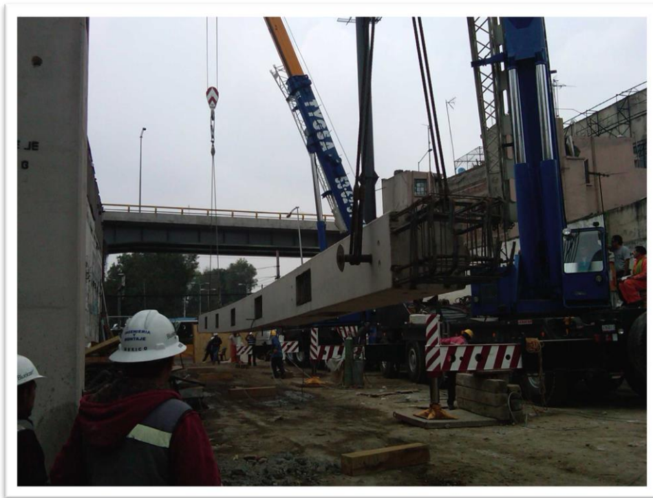
Figura 4.37. Una vez adecuados los niveles de placas y pernos, se coloca perno en la cabeza de la columna para el izaje y montaje de la columna.
