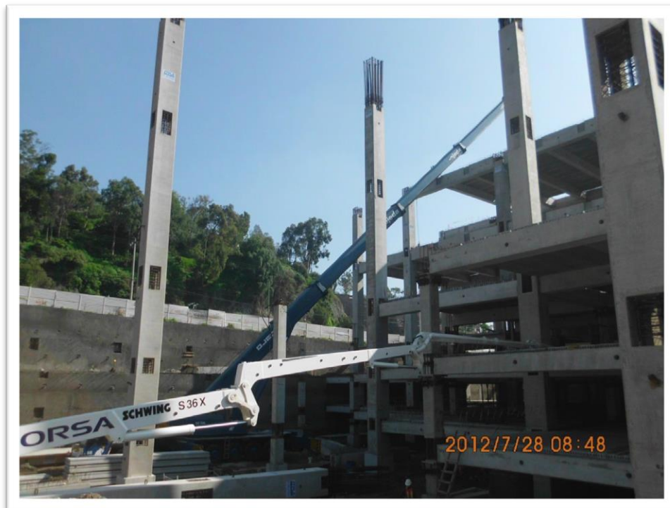
Figura 2.10. Columnas con nodo abierto. Las trabes se apoyan en la columna mediante ménsulas metálicas reutilizables. Proyecto: centro comercial patio Santa Fe.
