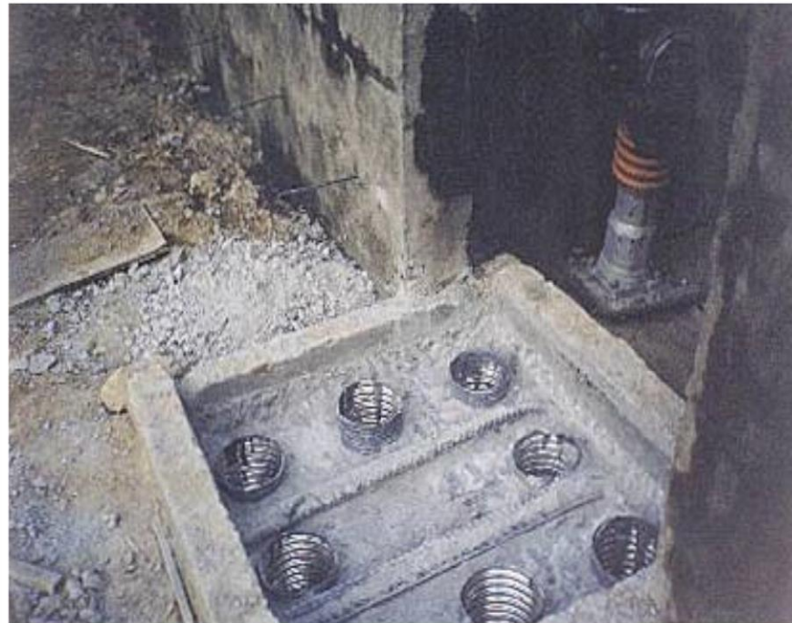
Figura 2.8. Ductos en cimentación para recibir vainas (armado longitudinal de columna). Proyecto: nave electrólisis Peñoles.
