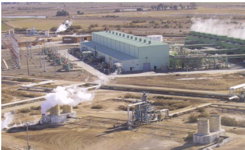
Figura 2.8. Central Geotérmica Cerro Prieto – B. C. Norte.
