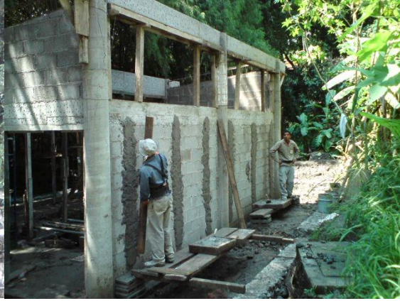
Foto 4.2.14 Trabes de cuarto de máquinas
