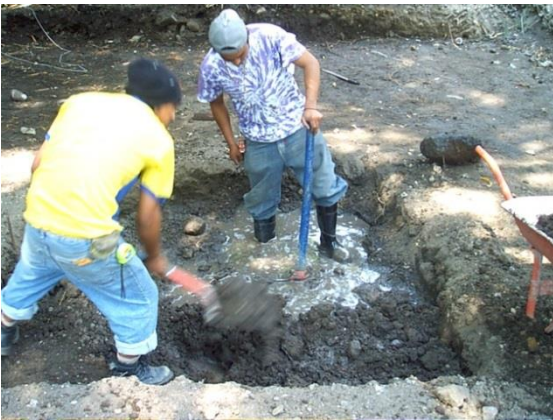
Foto 4.2.3 Inicio excavación fosa
