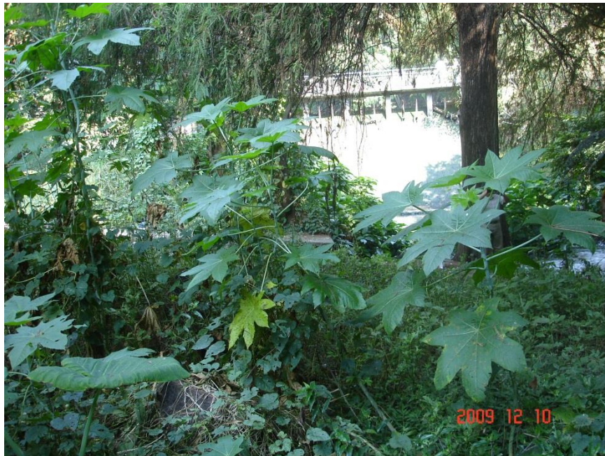
Foto A2-02 Inicio de los trabajos de desmonte y limpieza.
