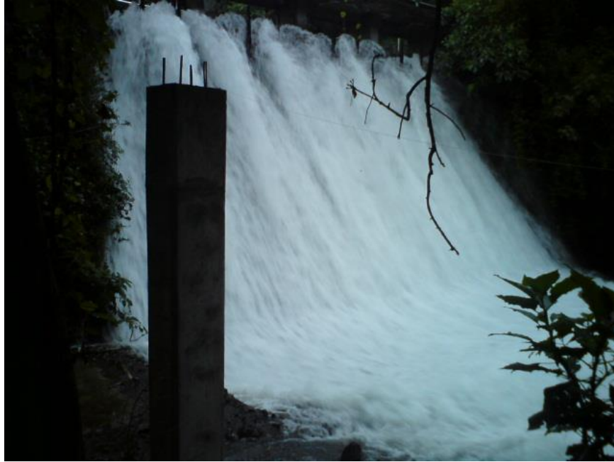
Foto A2-03 Vista de columna soporte de tubería y cortina.
