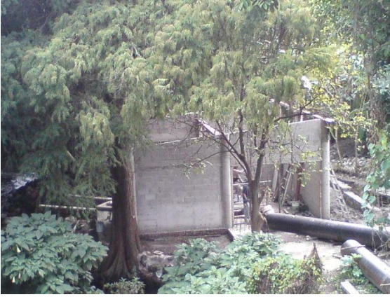
Foto 4.2.13 Muros de cuarto de máquinas
