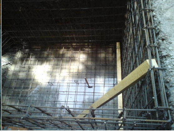
Foto 4.2.8 Armado de piso de fosa
