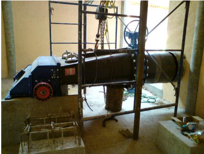
Foto A2-11 Vista de montaje de turbina, alimentación y válvula.
