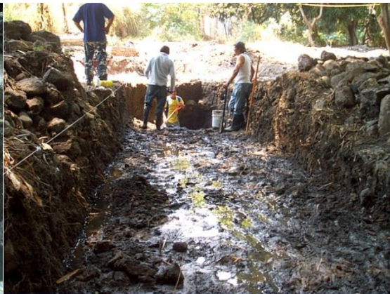
Foto 4.2.6 Excavación de salida/descarga
