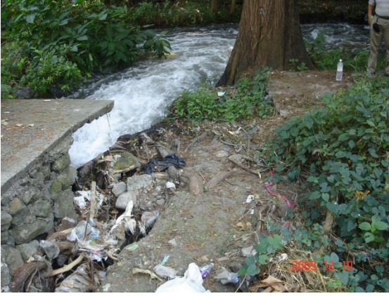
Foto 4.2.1 Desfogue de compuerta
