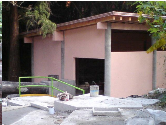
Foto 4.2.16 Cuarto de máquinas
