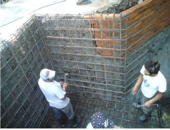
Foto 4.2.7 Armado muros de fosa
