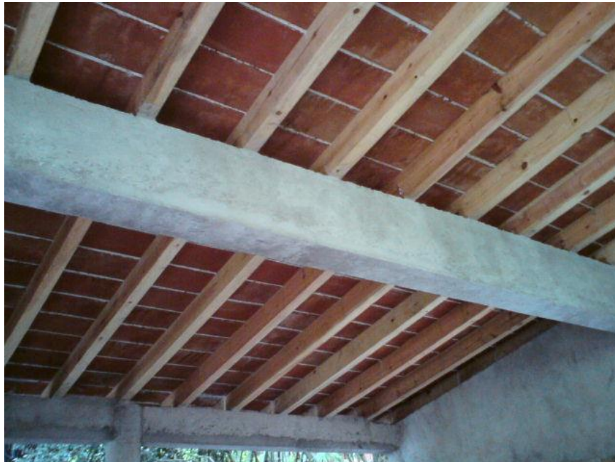
Foto A2-08 Vista de techo interior terminado.
