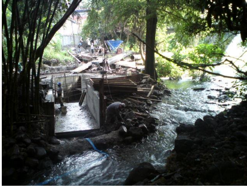
Foto A2-05 Vista de canal de desfogue y fosa de descarga.
