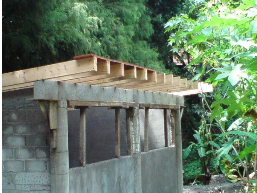
Foto A2-07 Vigas de madera de techo.
