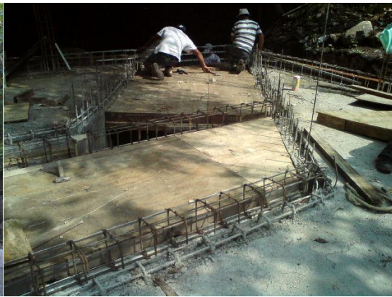
Foto 4.2.12 Losa tapa de fosa y descarga
