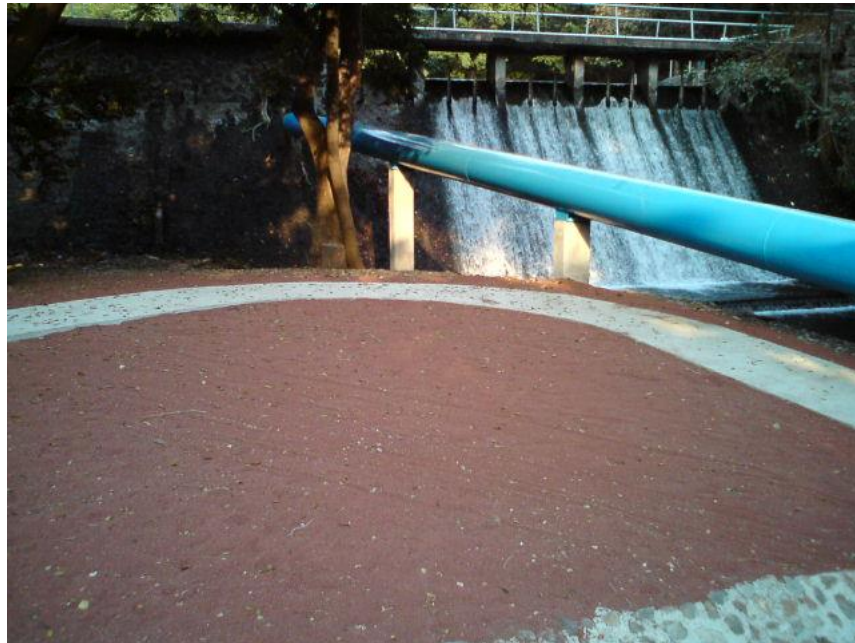
Foto A2-10 Vista de tubería de alimentación, vanos y cortina.
