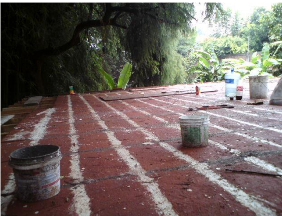
Foto 4.2.15 Celosía de losa
