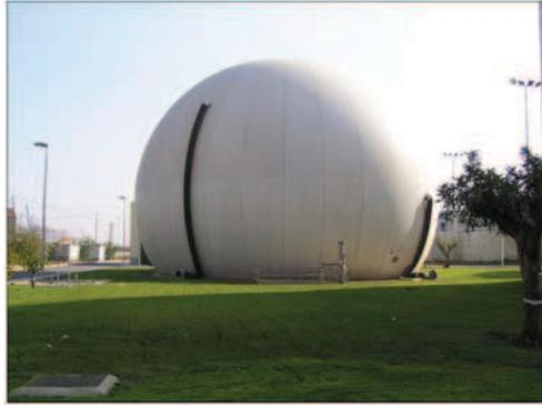
*Figura 2. 7 Gasómetro inchable*
