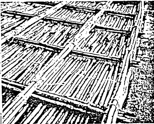
Foto No. 8, Acercamiento a las fajinas convencionales de "torones" y vacas de Mangle.
