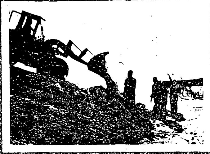
1. APLICACIÓN DE LA MEMBRANA TYPAR debajo de la capa que previene la erosión del suelo. Se coloca un colchón de arena sobre la membrana para protegerla durante la construcción.
