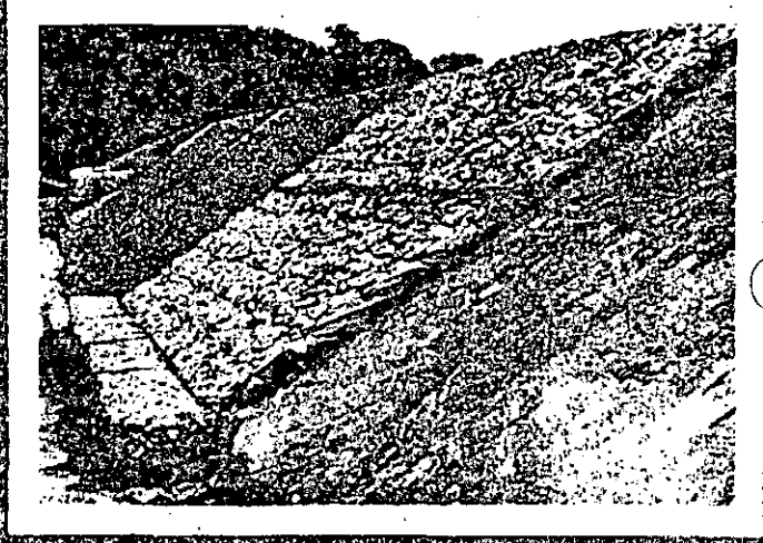
4. TYPAR cubre el espacio entre el muro y el talud, evitando la erosión del suelo.
