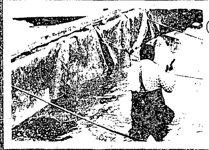
2. MUROS DE CONTENCION: Después de que el suelo sea nivelado con material TYPAR®, se evita el deslave con la coque que se acumula detrás del muro.
