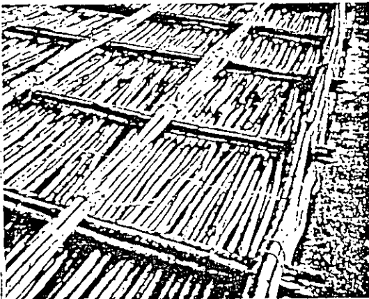
Foto No. 8. Acercamiento a las fajinas convencionales de "torones" y vacas de Mangle.
