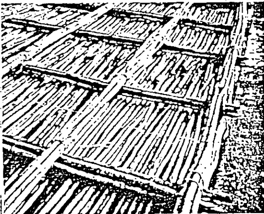
Foto No. 8, Acercamiento a las fajinas convencionales de "corones" y vacas de Mangle.
