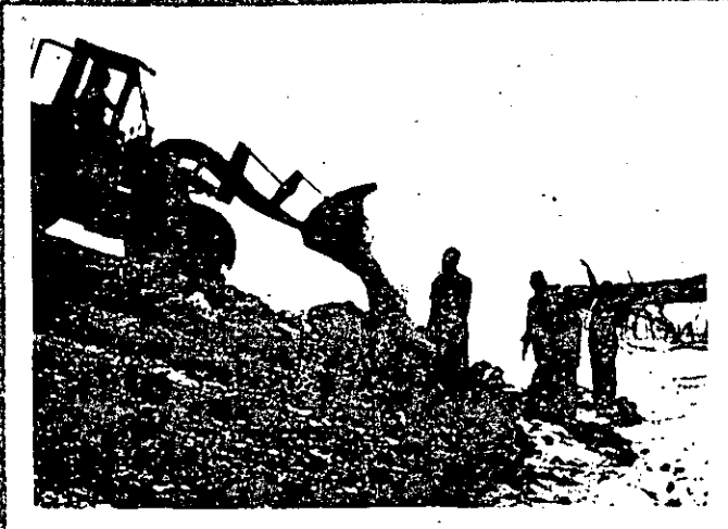
1. LAYING TYPAR Se ampara TYPAR debajo de la capa de arena para la erosión del suelo. Se coloca un colchón de arena sobre la membrana para protegerla durante la desmontaje de la
