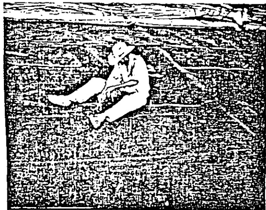
Foto No. 10. aspecto de las operaciones de incorporación de la Geored Plástica (fabricada en Mexico) al Geotextil tejido (de importación). Las operaciones de cosido las realizan personal no especializado con cordel y aguja de pescador.
