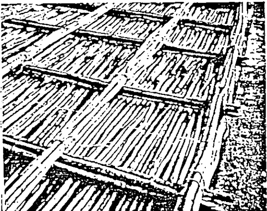
Foto No. 8, Acercamiento a las fajinas convencionales de "toronés" y vacas de Mangle.
