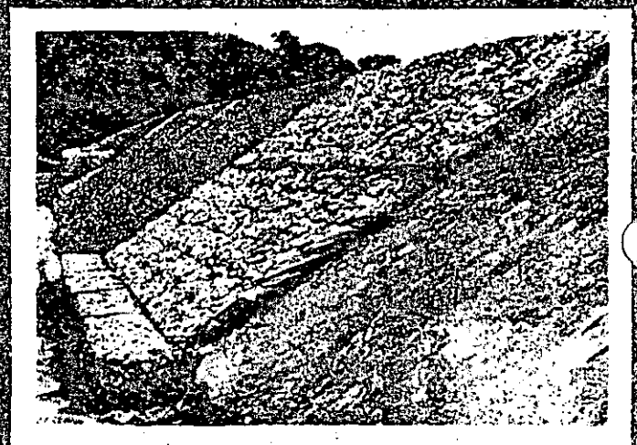
4. TYPAR Colocado por debajo de la estructura de 2000 mm de altura. El proceso de instalación debe ser similar al de la instalación de un muro de 1000 mm de altura.
