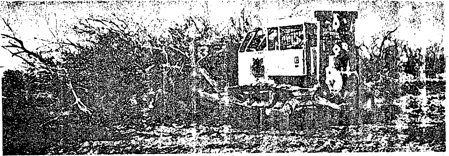
TRACTOR AMONTONANDO LA MALEZA PRODUCTO DEL DESMONTE.
