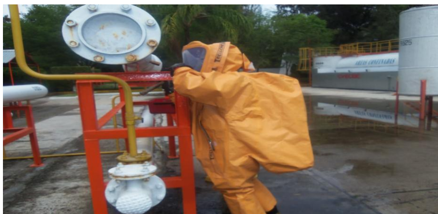
Figura 5.11. Proyecto de control de fugas en intercambiadores de calor.
