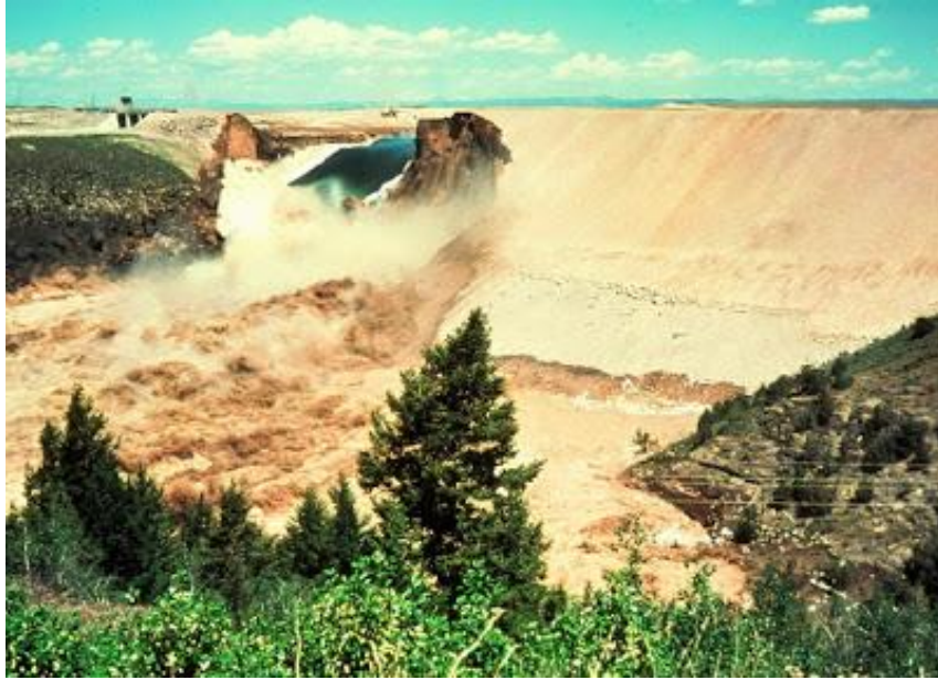
Figura 9: Brecha Presa Teton.
