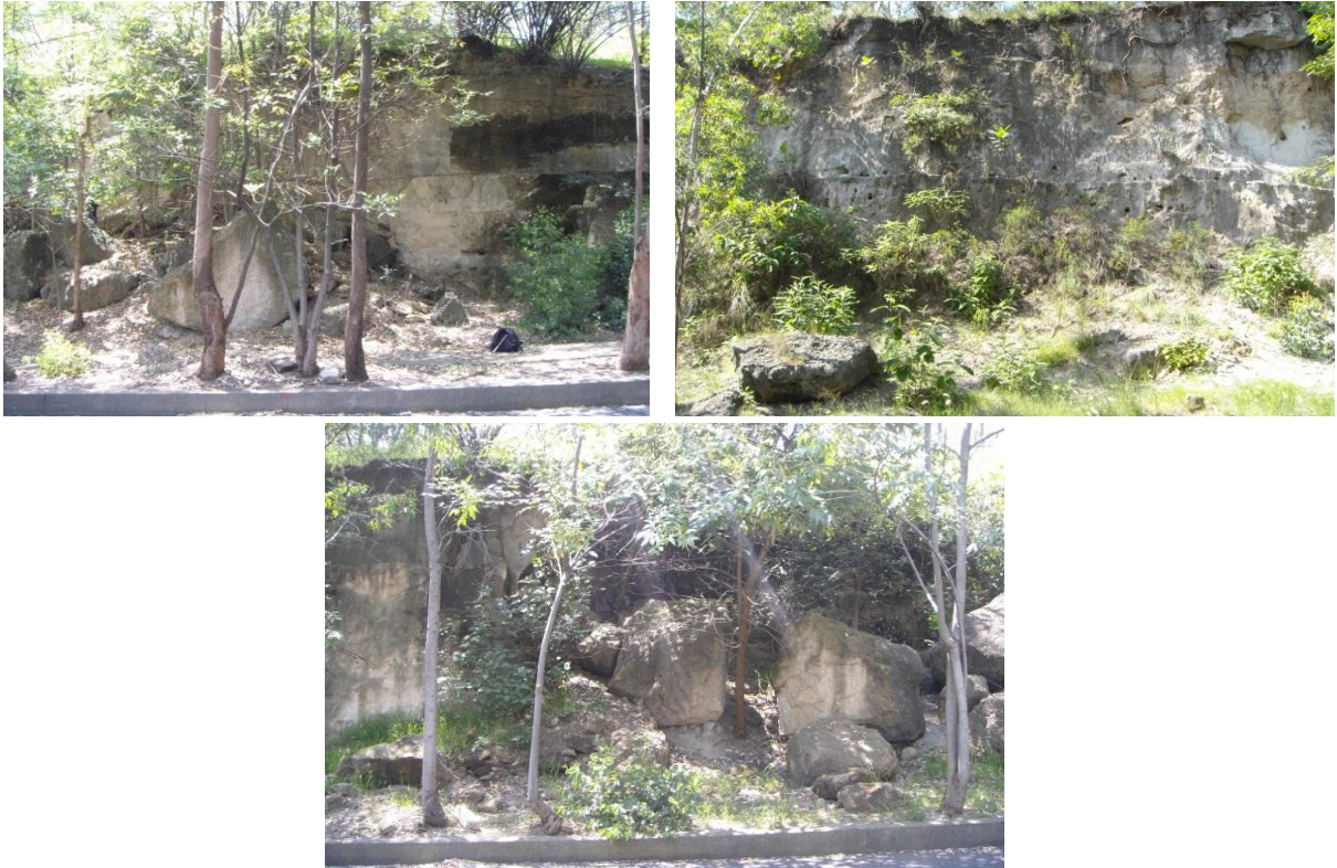
Figura 1.3 Caídos presentes a lo largo del talud ubicado sobre el circuito de la avenida Joaquín Clausell, a un lado de la Barranca de Dolores.
