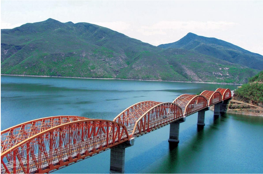
Figura 1.2 Puente Infiernillo (armadura)
