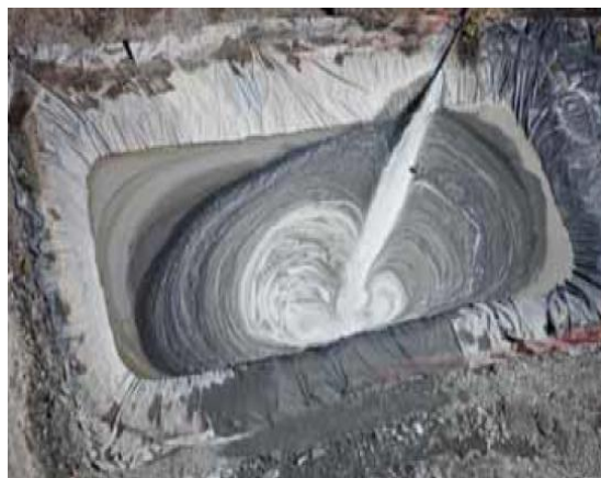
Figura 6.29. Almacenamiento de fluido de aguas residuales.
