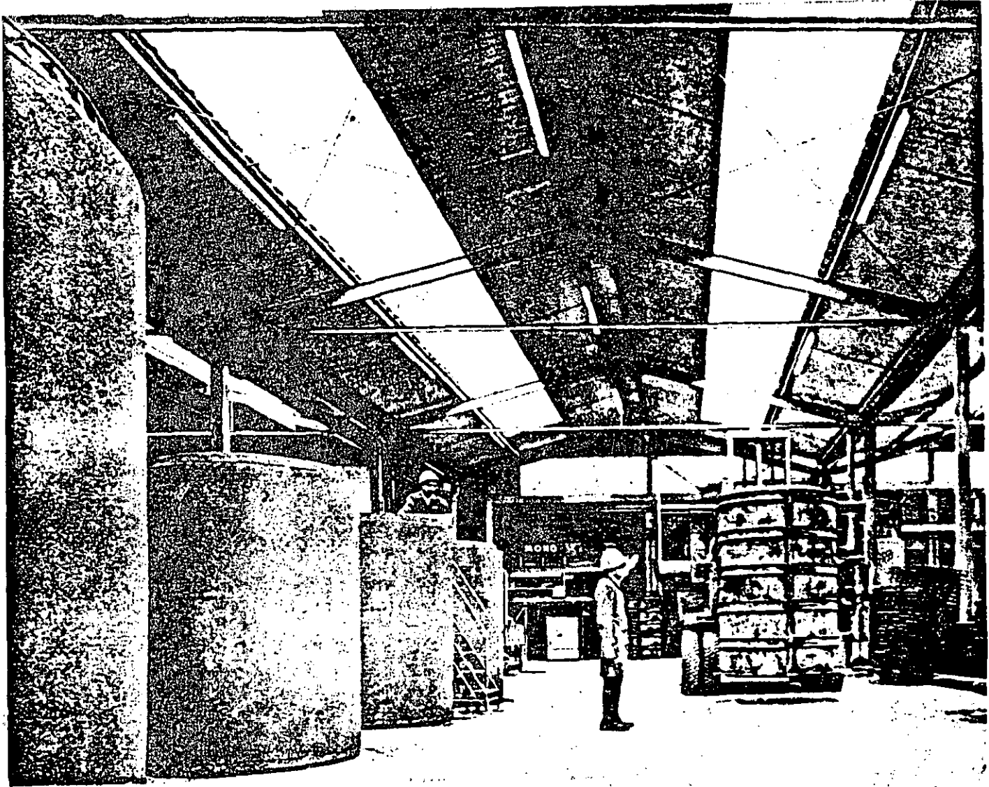
Tubos de 2 mts. de diámetro.
