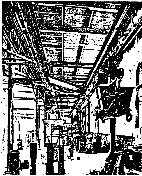
Transporte de concreto en el interior de una planta de prefabricación. Sistema de monorraíl.
