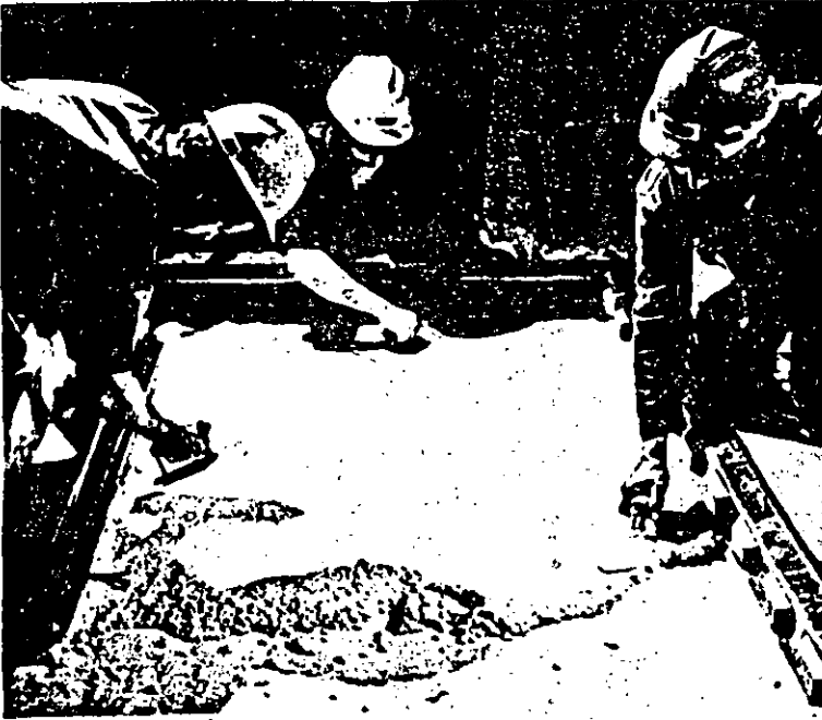
Molde metálico para el colado horizontal de paneles. En este caso se utilizó cemento blanco y agregados expuestos con un retardador superficial.
