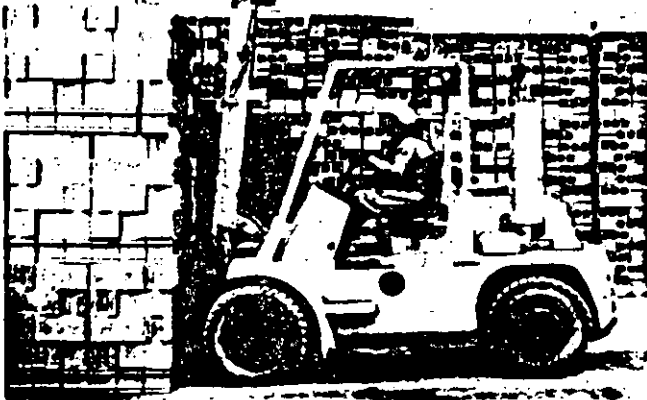
Manejo en planta de blocks de concreto.
