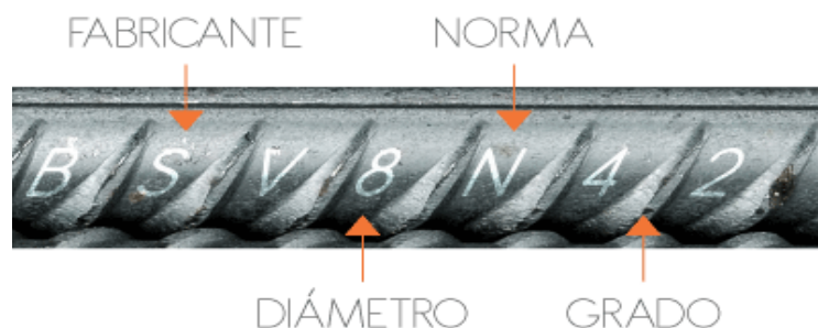
Figura 4.4 Marcas de identificación en acero de refuerzo
