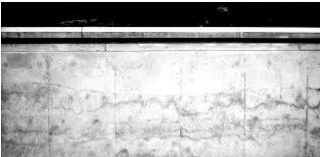
Figura 5.7 Líneas de flujo que pueden ser confundidas muy a menudo con juntas frías, pero que se evitan con una secuencia planeada de colado, una disposición adecuada y suficiente de equipos de colocación y las prácticas de vibrado descritas.
