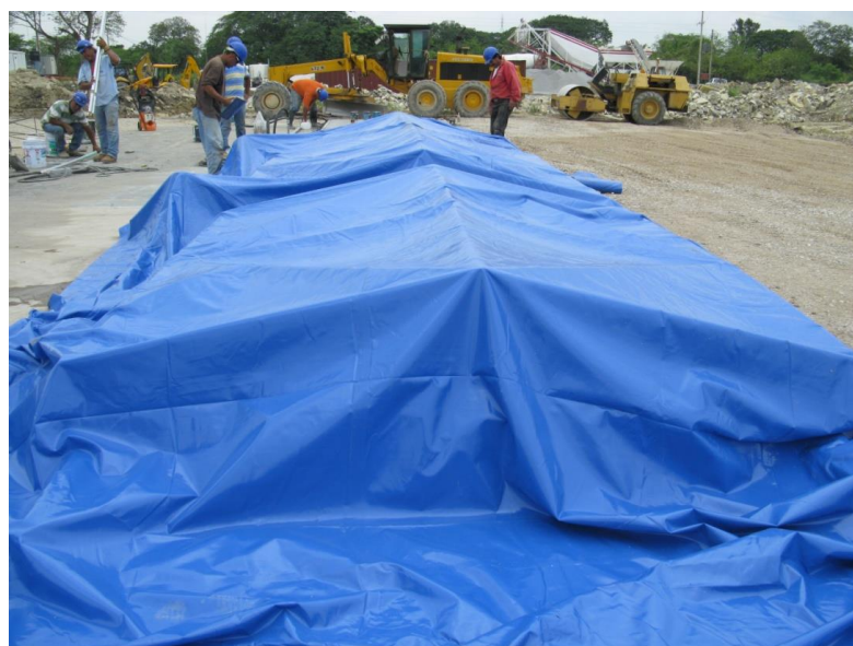
Figura 4.2 Lona térmica cubriendo muros prefabricados
