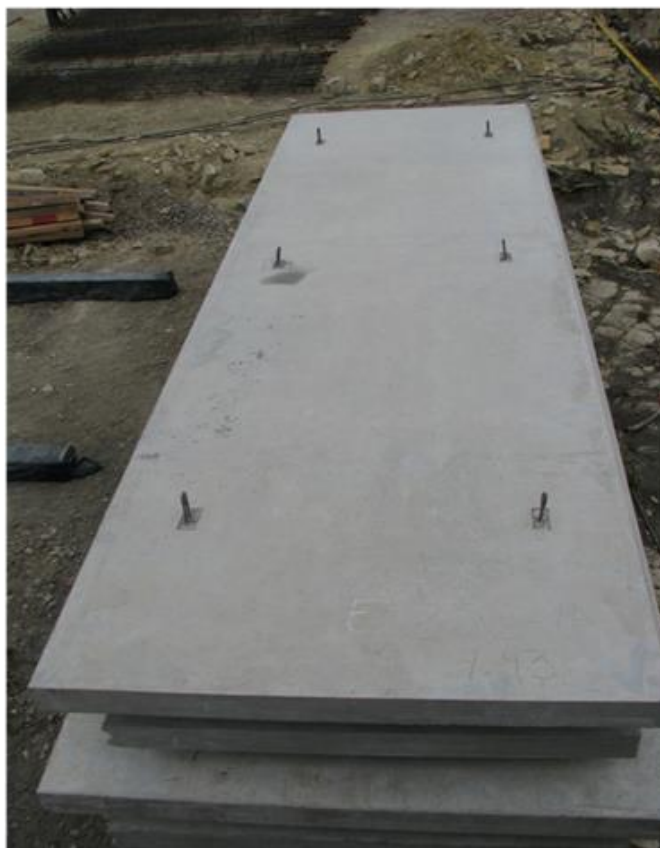
Figura 4.14 Muros prefabricados en posición horizontal
