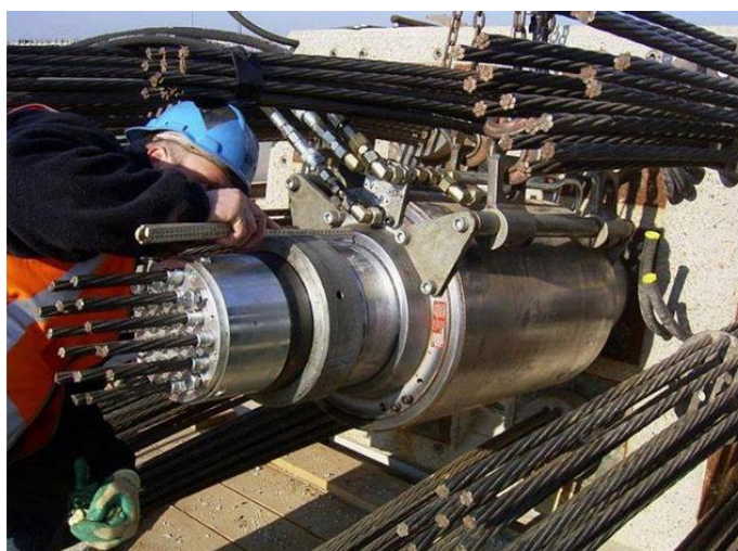
Fig. 6.23. Proceso de tensado con gato multitorón.
