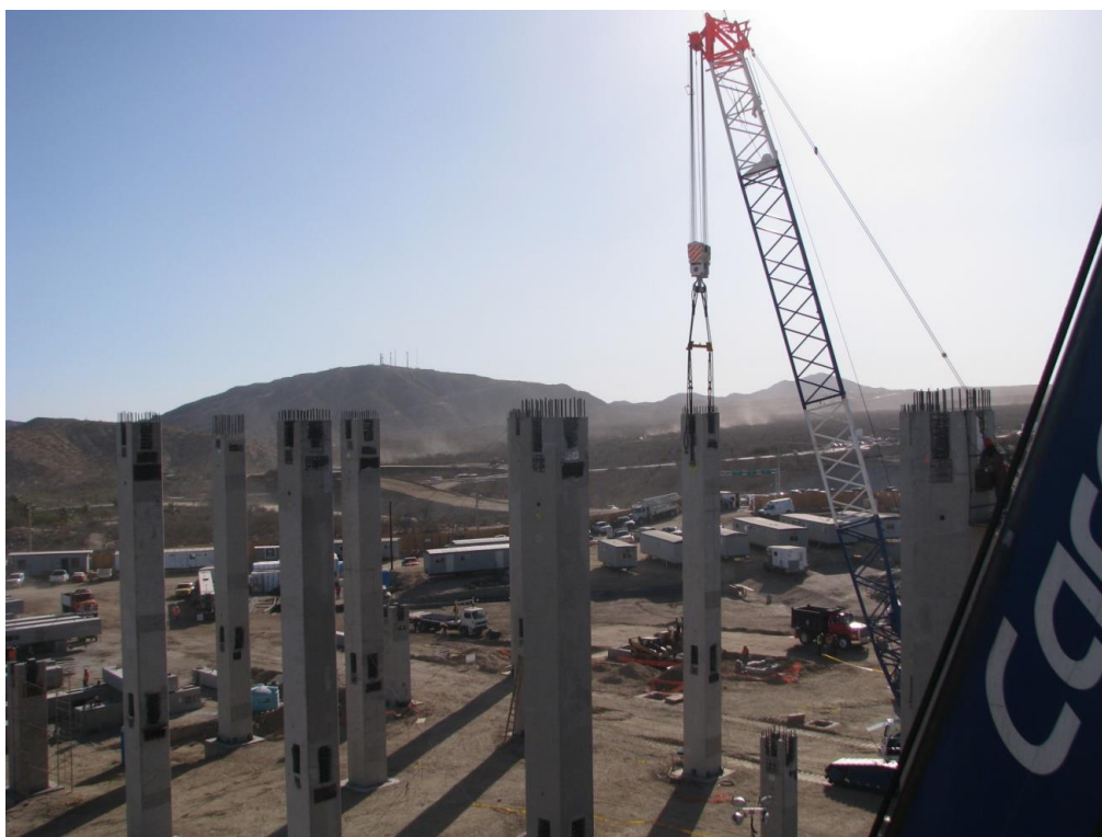
Fig. 9.1 Montaje de columnas obedeciendo cierta secuencia preestablecida.
