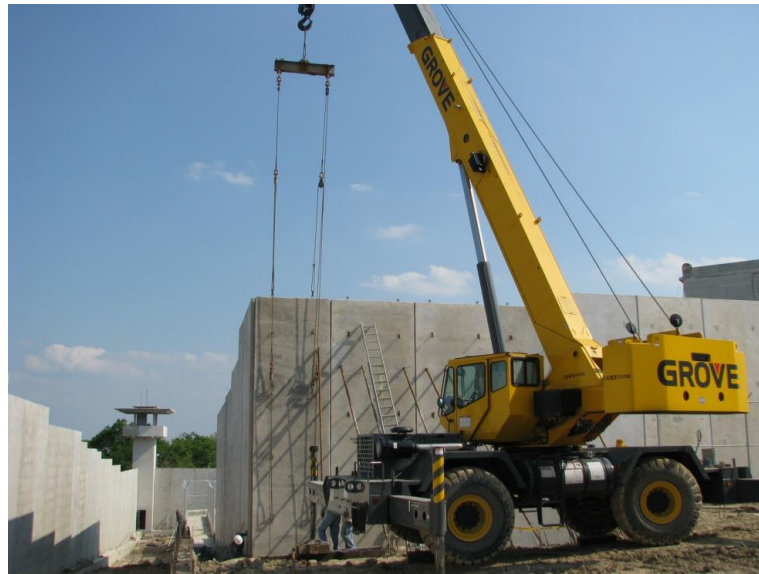
Fig. 9.2 Grúa hidráulica todo terreno montando muros prefabricados
