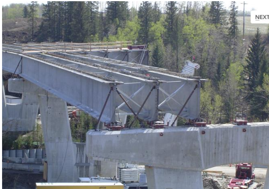
Fig. 9.16 Sujeción lateral provisional de traveses
