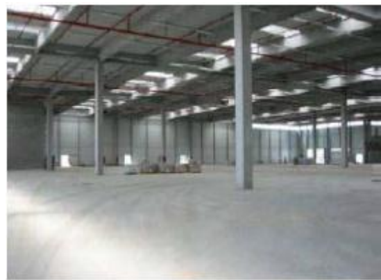
Pavimento sin juntas de contracción “ Fercam ” (Milán, Italia)
