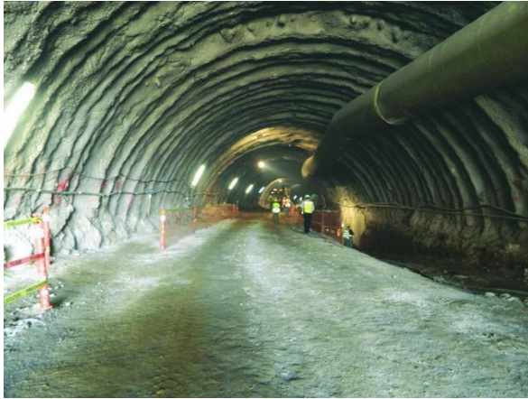
Concreto lanzado–Revestimiento primario (Supevia poniente, Mexico D.F)
