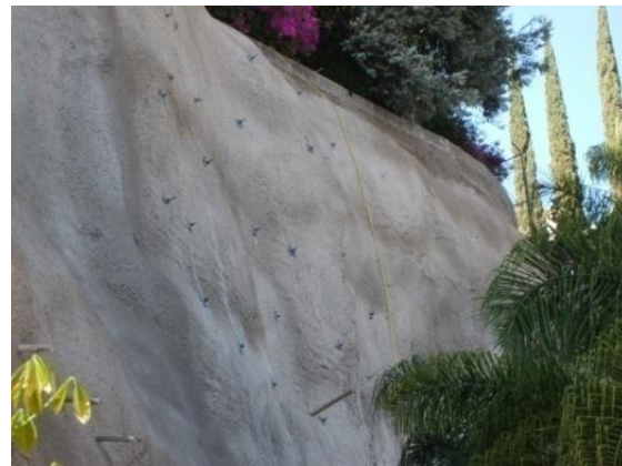
Concreto lanzado-Estabilidad de talud (Carretera Durango-Mazatlán, México)
