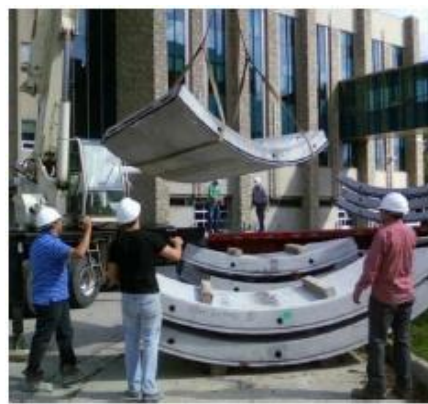
Dovelas prefabricadas (EEUU) para T.M.B (Tunnel Boring Machine)
