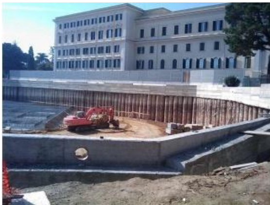
Pantalla de pilotes tipo CPI-8 (Catalunya, España)
