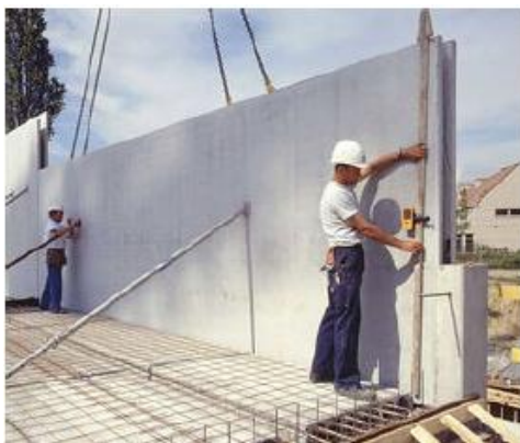
Elementos prefabricados (EEUU, Colombia)
