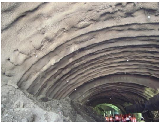
Revestimiento primario-Concreto lanzado (Túnel Xicotepec, México)
