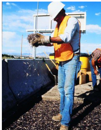
Fig. 2.4 En la producción del SIFCON, las fibras de acero se colocan en la superficie antes de colocar la pasta de cemento.
