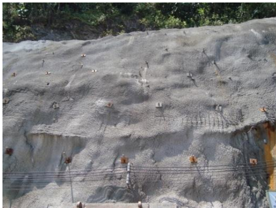
Concreto lanzado-Estabilidad de talud (Carretera Durango-Mazatlán, México)
