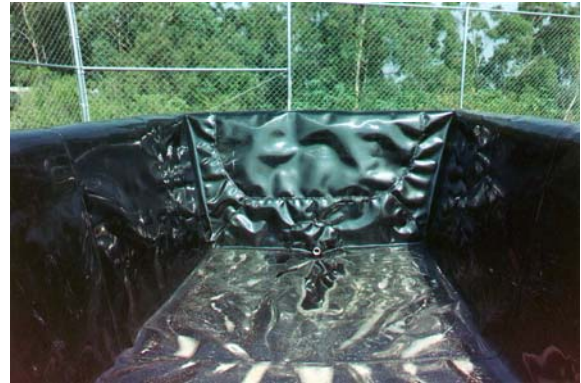
Figura A4.3 Paredes cubiertas con la geomembrana
