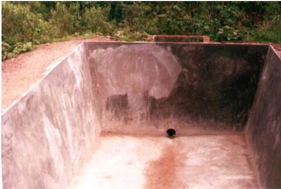
Figura A4.2 Paredes de concreto del HAFVD
