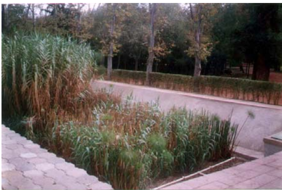
Figura A4.9 Vista general de la poda parcial en el humedal
