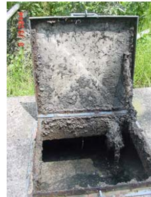
Figura 3.2a Sedimentador de Zona Cultural
