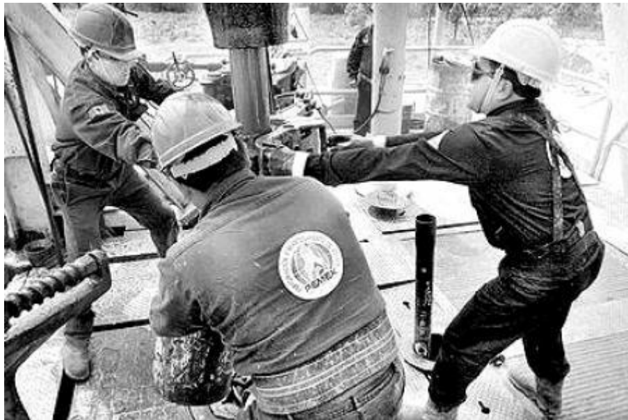
Figura 3.5, Operación de cambio de tubería
