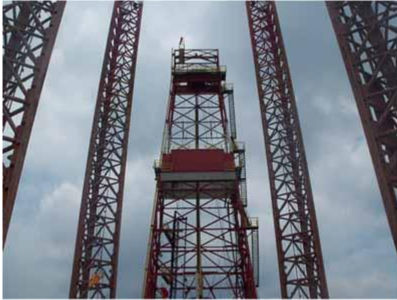
Figura 4.6, Torre de perforación
