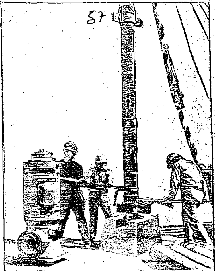
ILUSTRACION No. 4 Enroscando el juego de tazones al tubo de succión.
