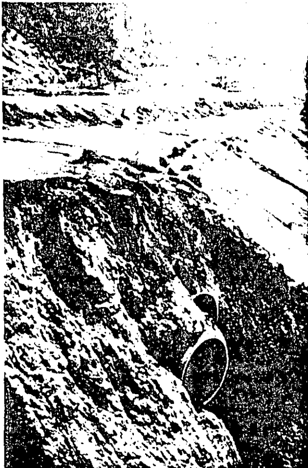
Erosión por infiltración en una alcantarilla mal colocada en el cuerpo de la terracería.
