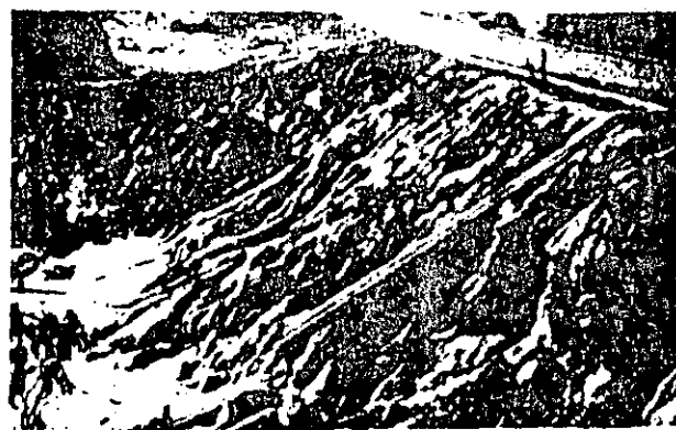
Efecto de erosión. Nótese el lavadero descubierta.
