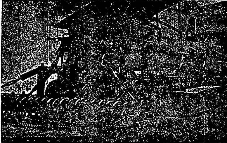
Fotografía 5 - Se está regando una emulsión de RECLAMITE sin diluir sobre el pavimento asfáltico escarificado y sin compactar. El RECLAMITE penetra rápidamente para revitalizar y replastificar la mezcla asfáltica vieja. A continuación se coloca el recubrimiento con la nueva mezcla asfáltica, y se compacta.
