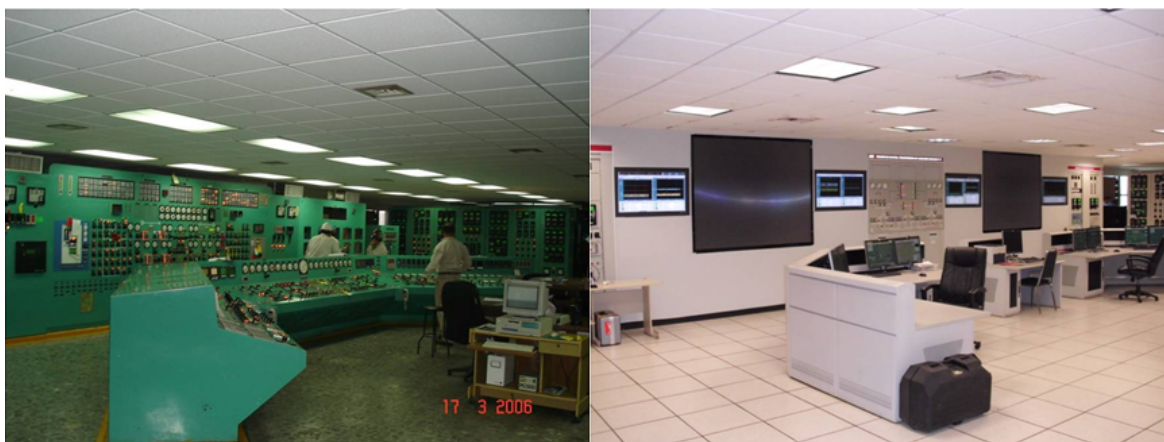
Figura 2.2. Altamira. Antes (izquierda) y después (derecha) de la modernización.
