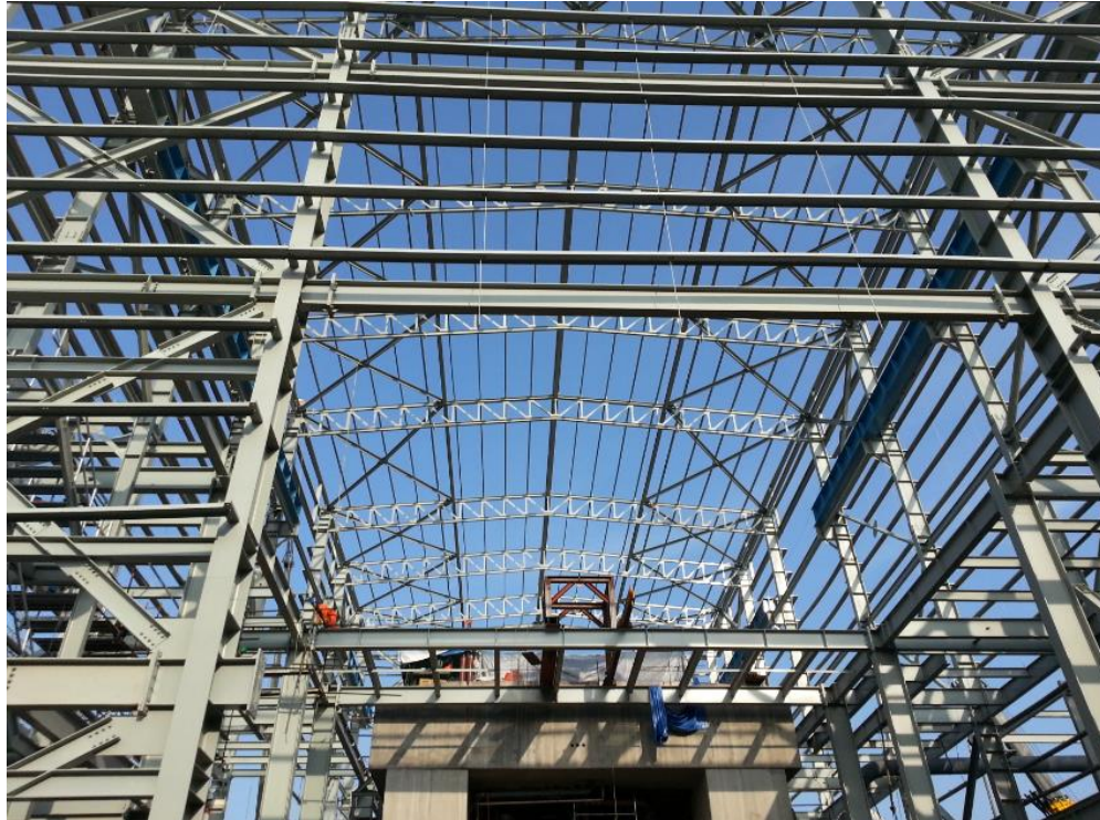
Figura 2.23 Montaje frontal de la estructura de la casa de máquinas.
