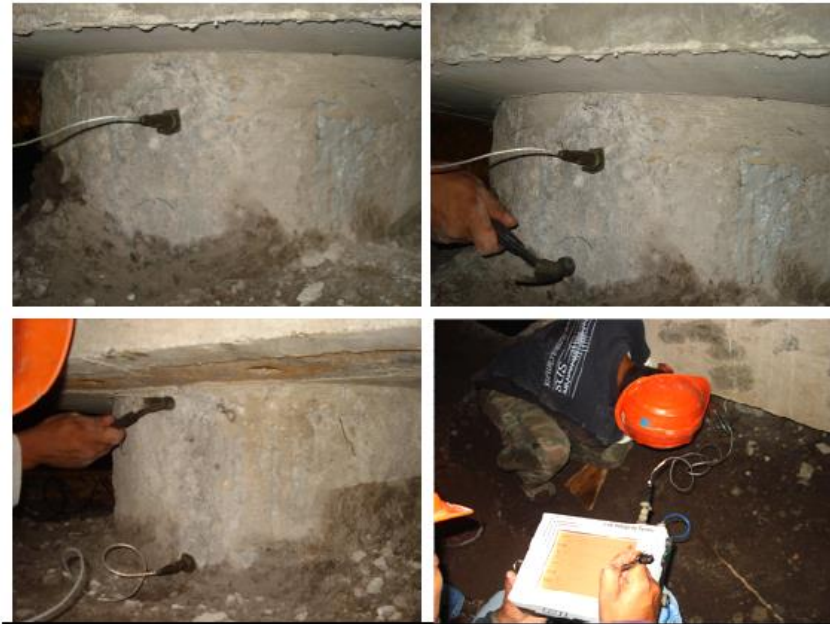
Figura 5.22 Ejecución de la prueba de integridad.
