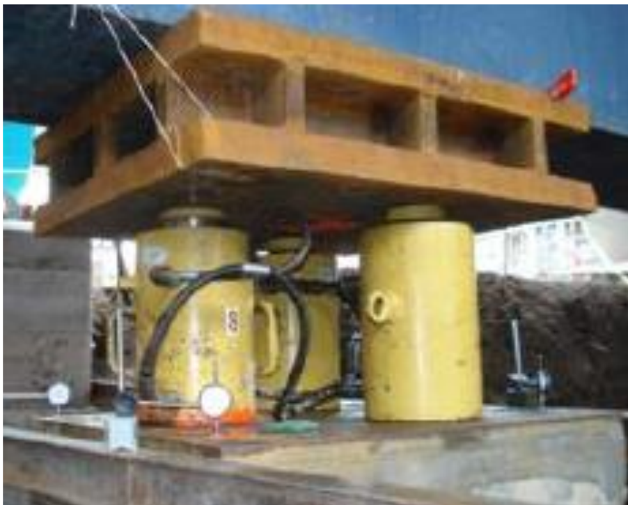
Figura 5.19 Pruebas de carga para compresión en casa de máquinas.
