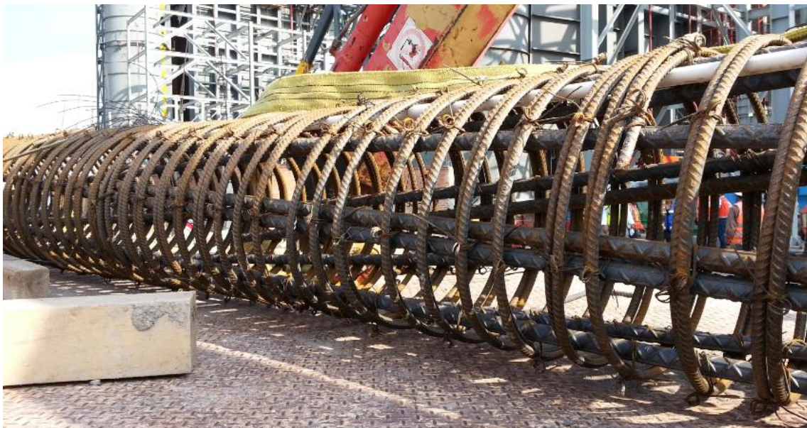
Figura 4.11 Armado de acero para la pila.
