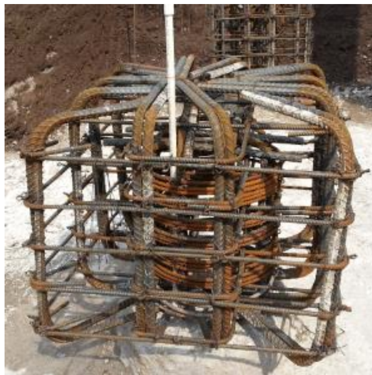
Figura 4.12 Armado de acero para cabezal y dado de concreto.
