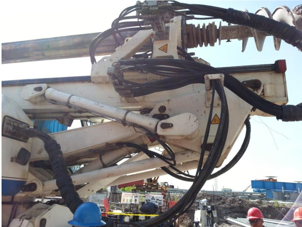
Figura 5.10 Equipo de perforación.
