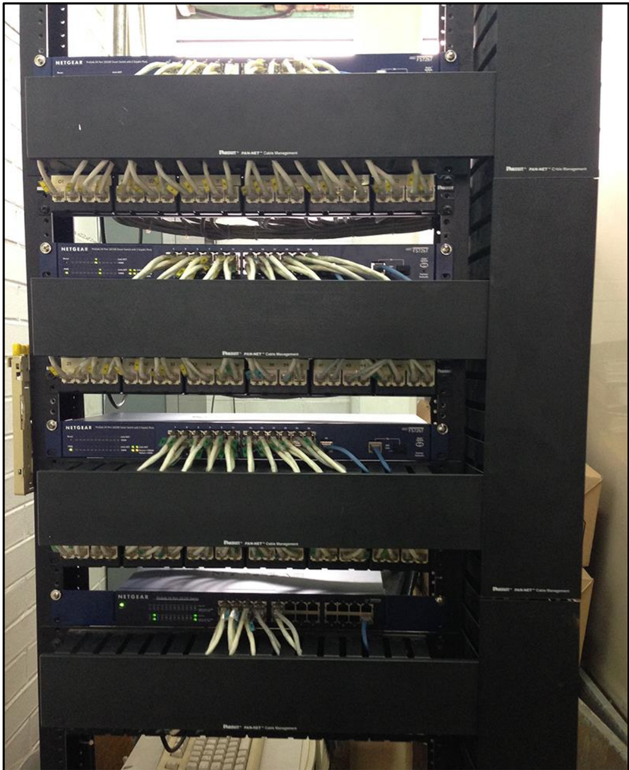
Figura 6. 10 Instalación final de equipos y conexiones en el rack
