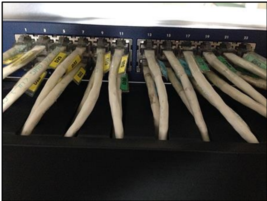
Figura 6. 7 Etiquetado de conexiones del segundo switch
