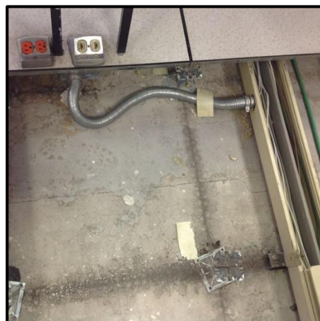
Figura 2. 9 Tendido terminal de cable a roseta de piso
