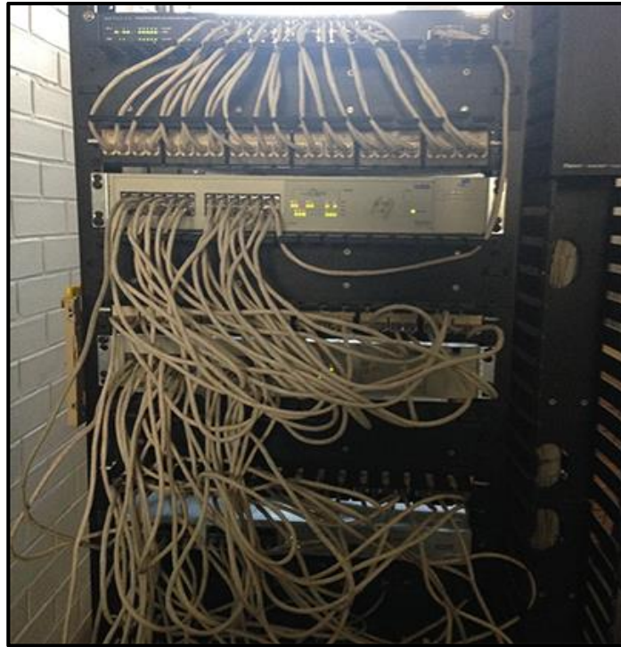
Figura 6. 2 Instalación del primer switch
