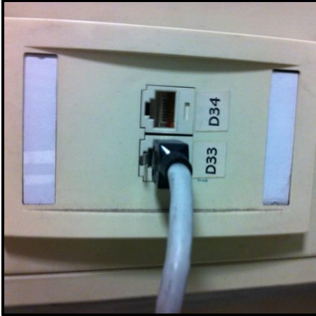
Figura 2. 10 Roseta en canaleta lateral
