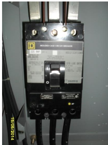
Imagen 2.55 y 2.56 tablero e interruptor 5A
