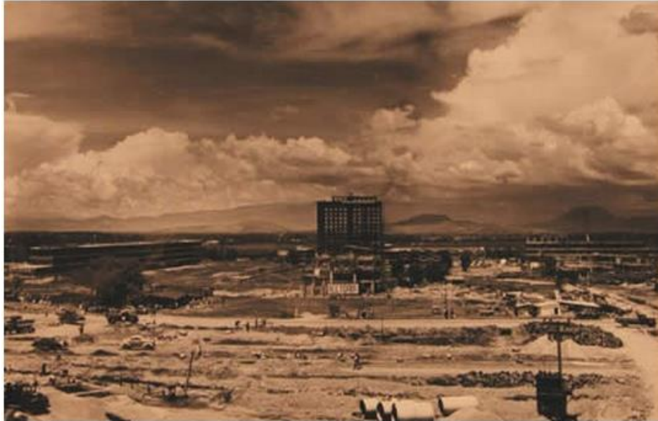
Imagen 2.2 “Construcción de C.U ”
