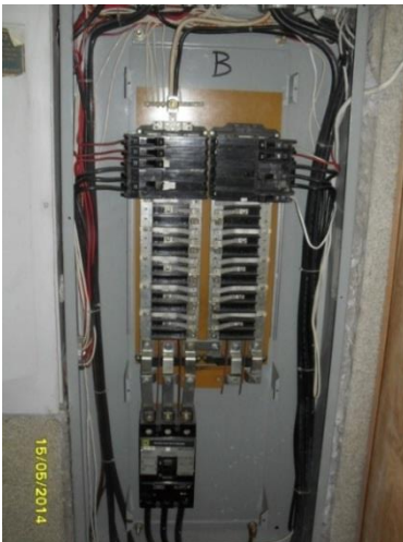
Imagen 2.55 y 2.56 tablero e interruptor 5A
