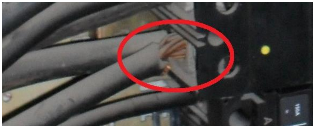
Imagen 2.13 Conductores capados
