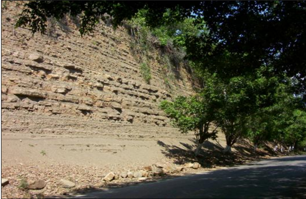
Fig. 2.10 Inter-estratificaciones cíclicas de areniscas arcillosas y arcillas limolíticas de la Megasecuencia Media (UNAM-CNH, 2012)
