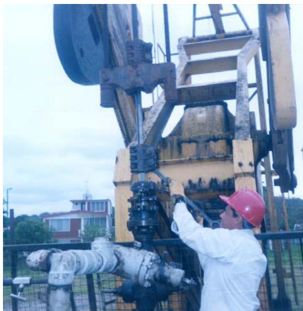
Figura 3.23. Retiro de la grampa.
