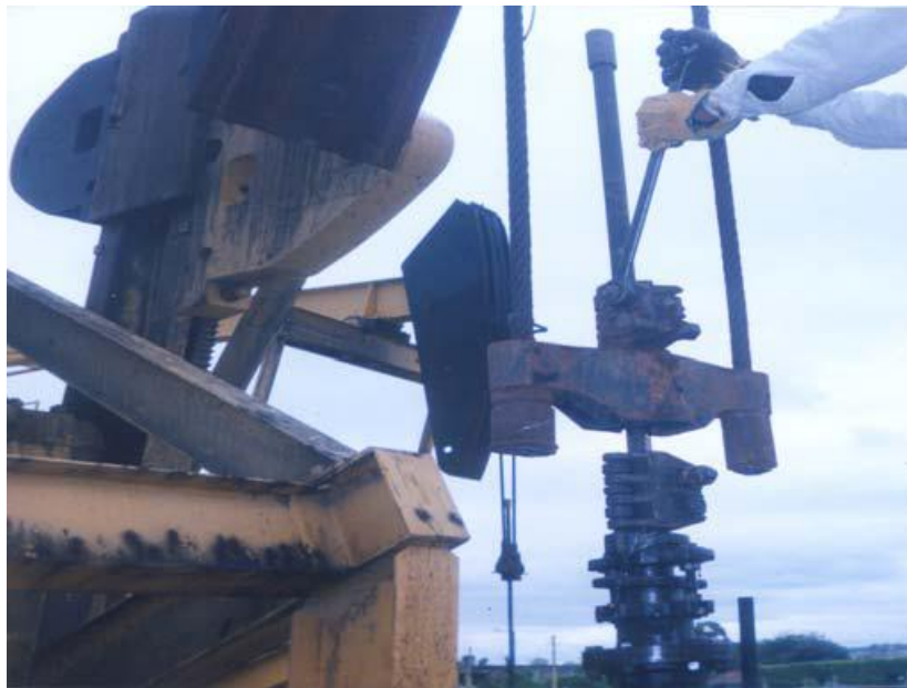
Figura 3.21. Colocación de la grampa.
