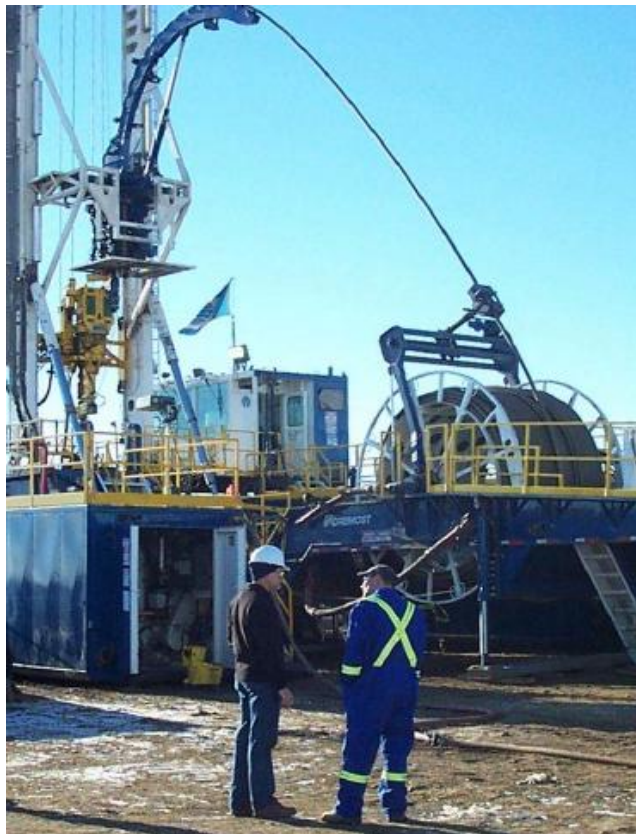
Figura 1.18. Equipo de perforación con tubería flexible (ConocoPhillips).
