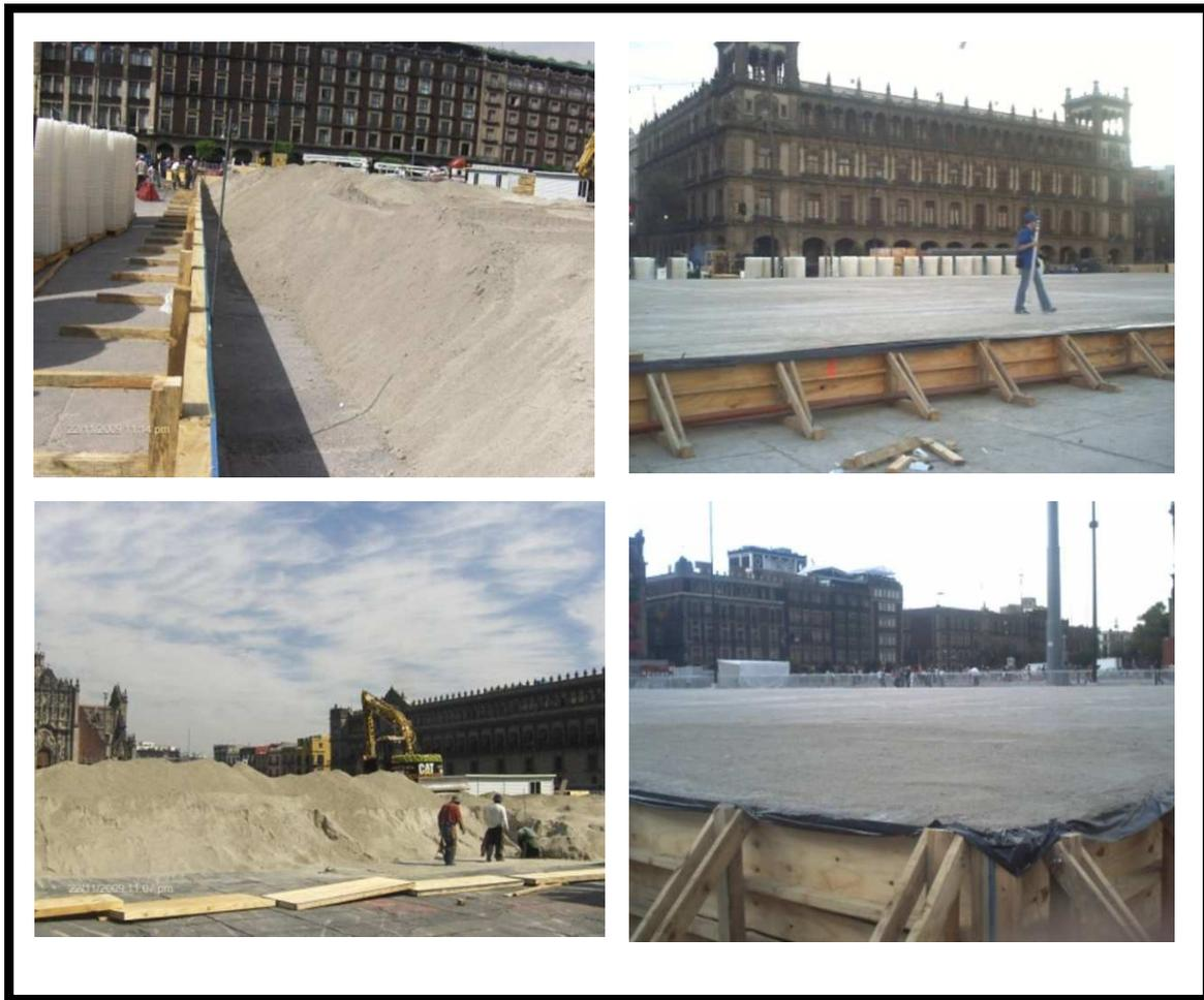
Figura 4.9 Proceso del montaje de la plancha de arena (Información recabada 2009).
