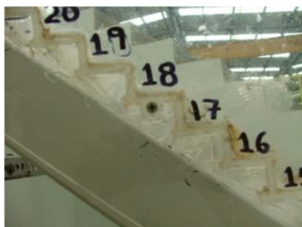
Ilustración 3.18 Dimensiones del escalón en prototipo : 1.49 (0.03) m huella 1.20 (2.4) m peralte
