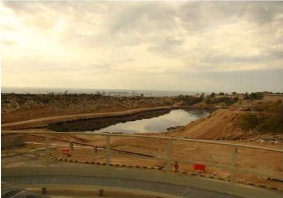
FIGURA 4.2. ESTANQUE DE RETENCIÓN. ISLA KHARG, GOLFO PÉRSICO.
