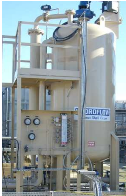
Figura 4.9 FILTRO DE CASCARA DE NUEZ HYDROFLOW.
