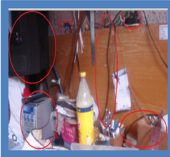
Fig. 8 Cables sueltos y uso de solventes
