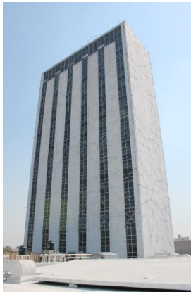
Figura 4. Fachada Sur de la torre del CCUT
