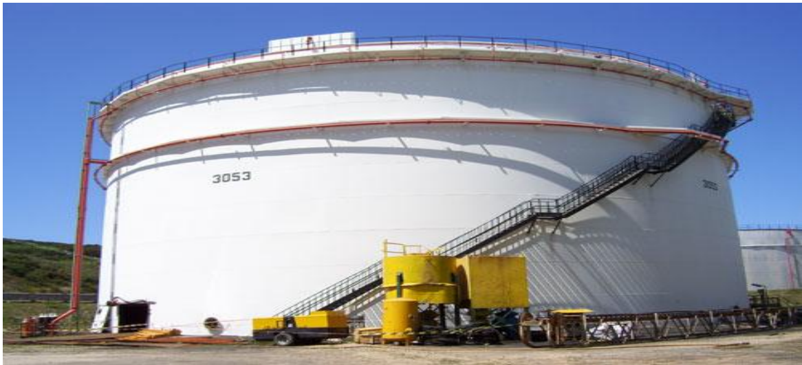
Figura 8. Tanque de almacenamiento de Techo Fijo.
