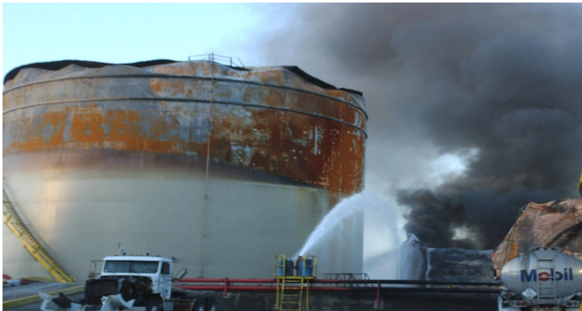
Figura 42. Incendio por Hundimiento de Techo.
