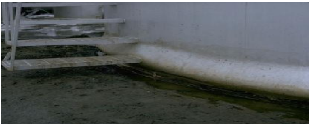
Figura 32. Pandeo “Pata de Elefante”.
