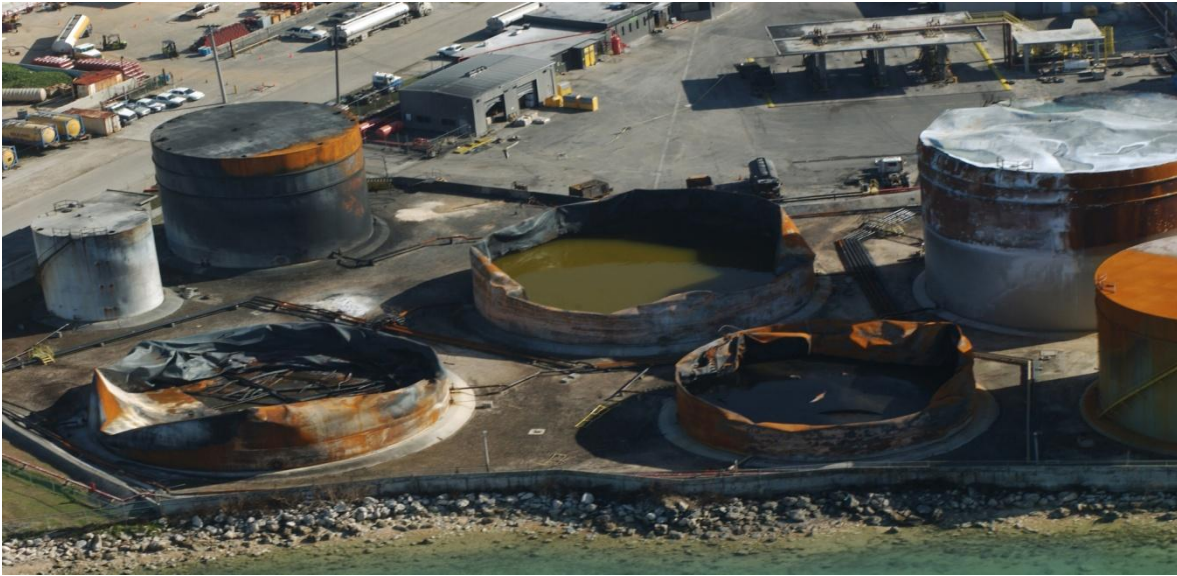
Figura 31. Colapso en Tanque Atmosférico de Almacenamiento.
