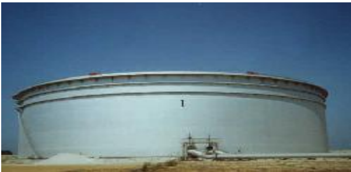
Figura 67. Tanque de almacenamiento que requiere reflejar la radiación solar (blanco)
