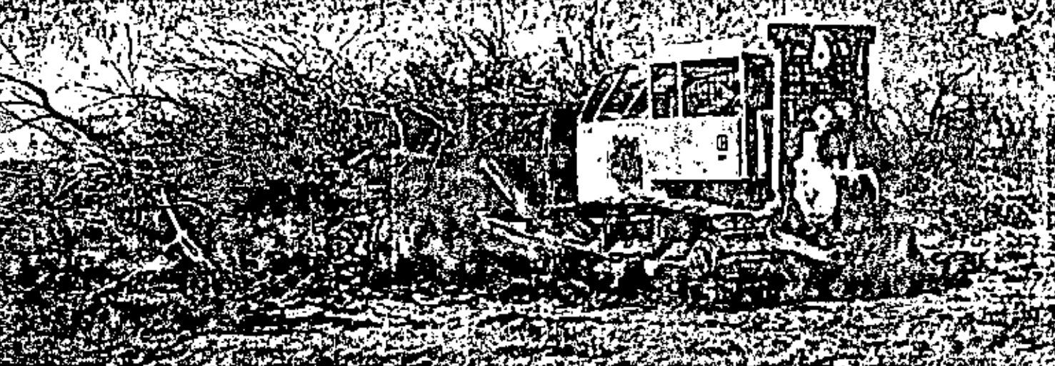
TRACTOR AMONTONANDO LA MALEZA PRODUCTO DEL DESMONTE.
