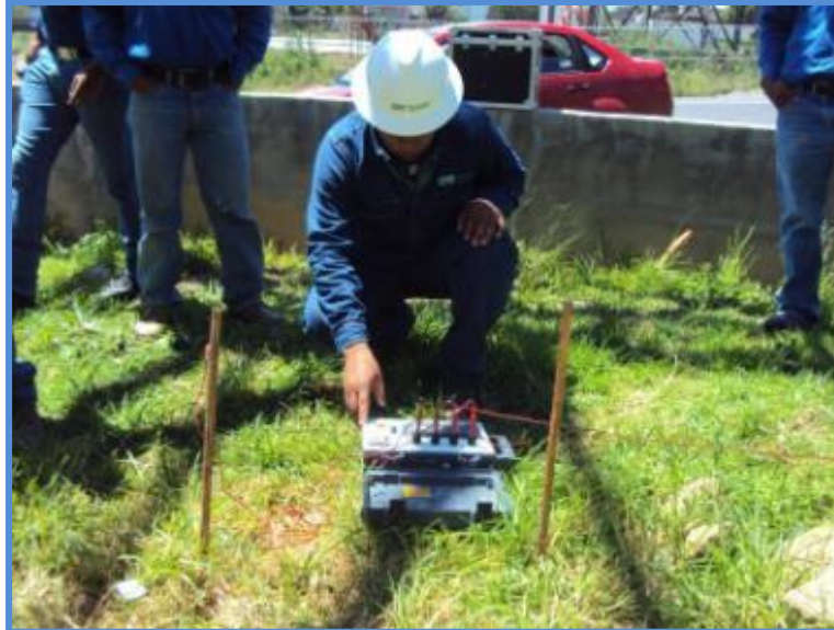
Figura 2.3.1-1 Personal de líneas realizando medición de resistividad del terreno
