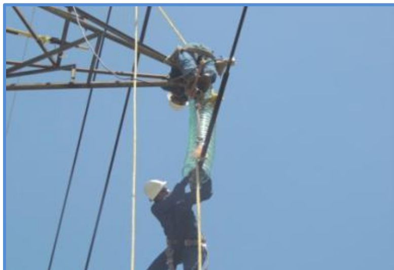
Maniobra cambio de aislamiento en estructura de suspensión
