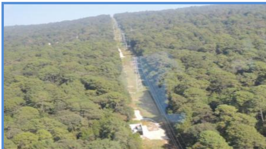
Figura 2.4-2 Derecho de vía de las líneas TOP-93050/93060-MOR de 230 kV
