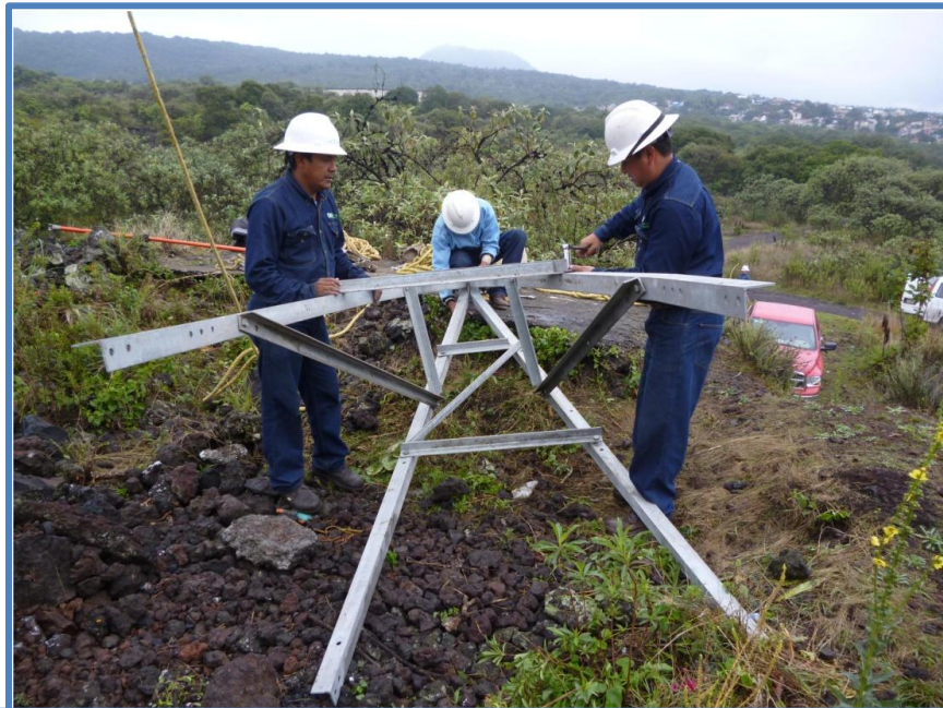
Armado de nueva cruceta de guarda para modificación de ángulo de blindaje
