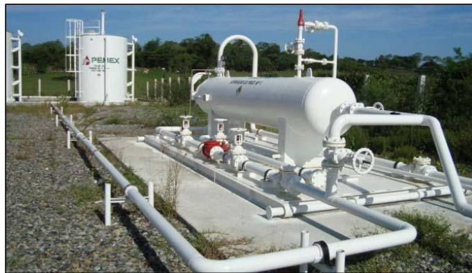
Figura 5.10. MSP - Separador, tanques (Academia de Ingeniería A.C, 2011).
