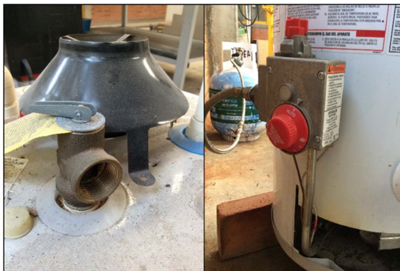
Figura 3.27 Válvula de alivio y termostato.
