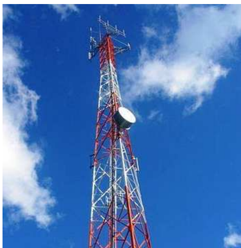
Figura 2.24 Torre auto soportada
