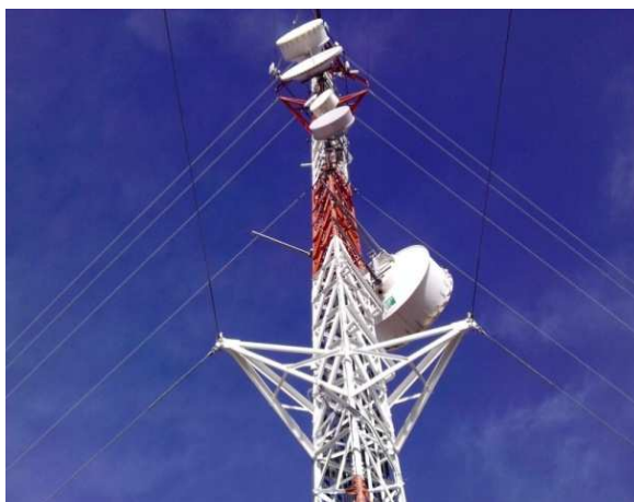
Figura 2.25 Torre arriostradas o atirantada
